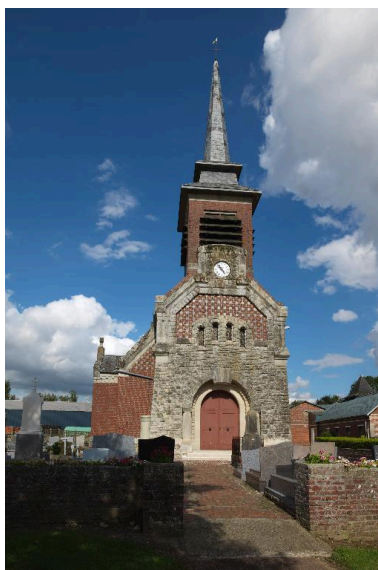
Vue générale. Phot. Marie-Laure Monnehay-Vulliet IVR22_20158000708NUC2A
