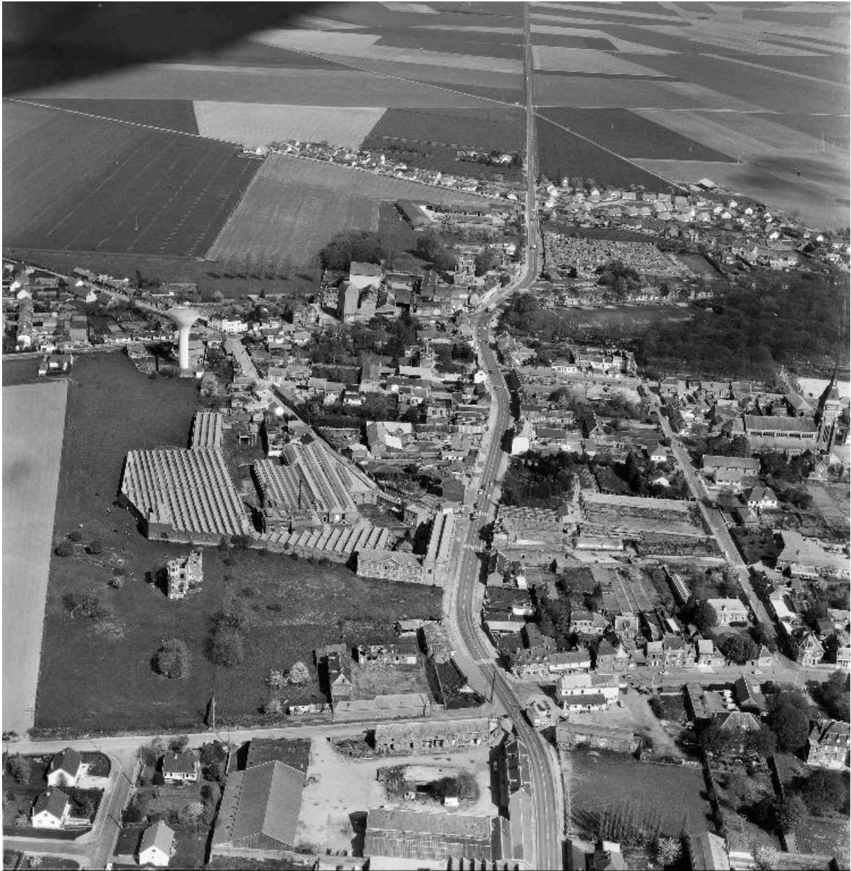
Vue aérienne montrant l'état de la propriété en 1988.
