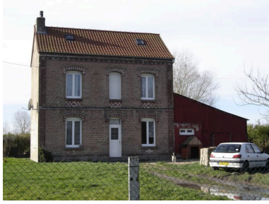
Vue générale. Phot. Inès Guérin IVR22_20058005414NUCA
