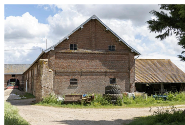
Partie d'un bâtiment agricole abritant l'ancien pressoir, vue depuis l'ouest. Phot. Marc Kérignard IVR32_20216000417NUCA
