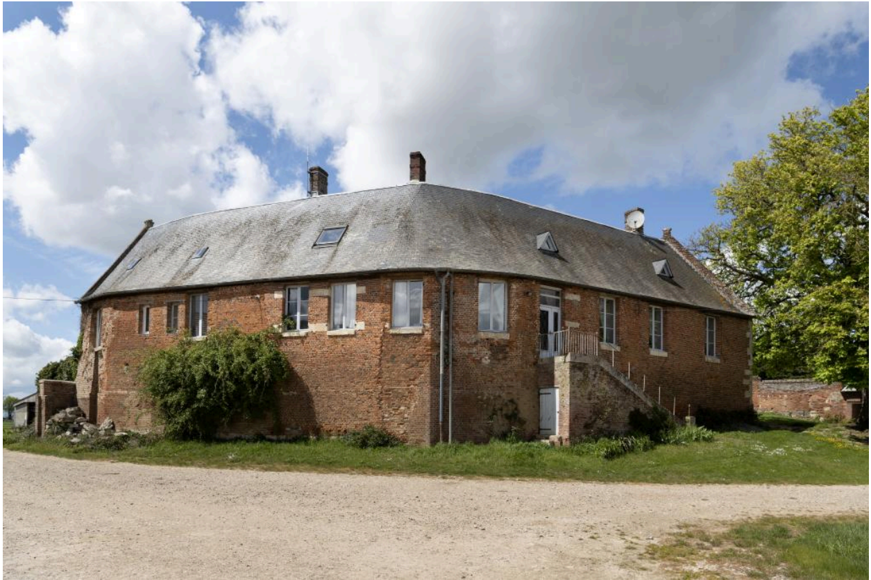
Logis reprenant la forme de l'ancien chemin de ronde de la forteresse médiévale, vue depuis le sud-est.
