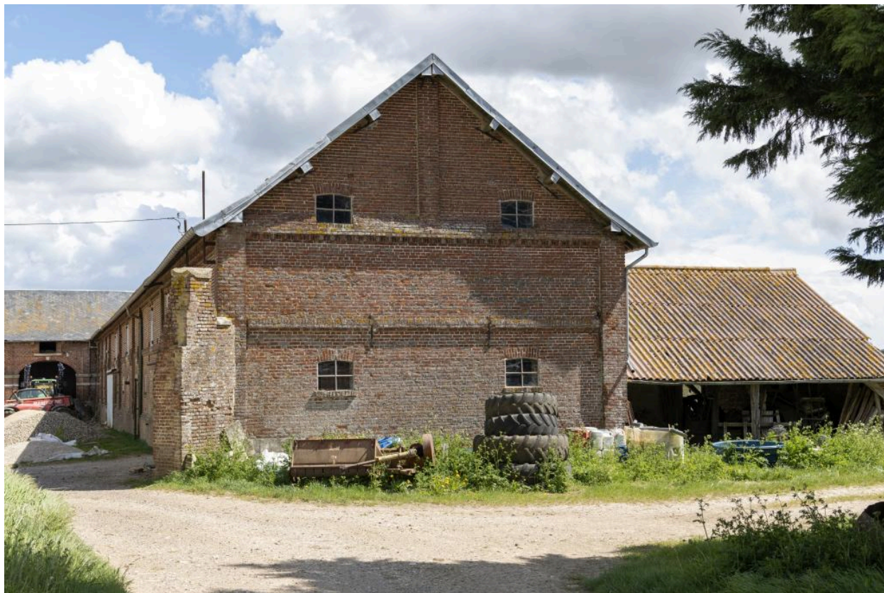
Partie d'un bâtiment agricole abritant l'ancien pressoir, vue depuis l'ouest.
