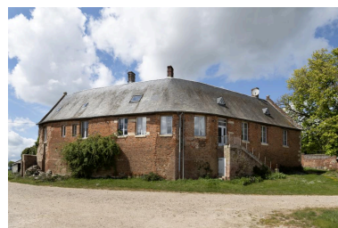
Logis reprenant la forme de l'ancien chemin de ronde de la forteresse médiévale, vue depuis le sud-est. Phot. Marc Kérignard IVR32_20216000420NUCA
