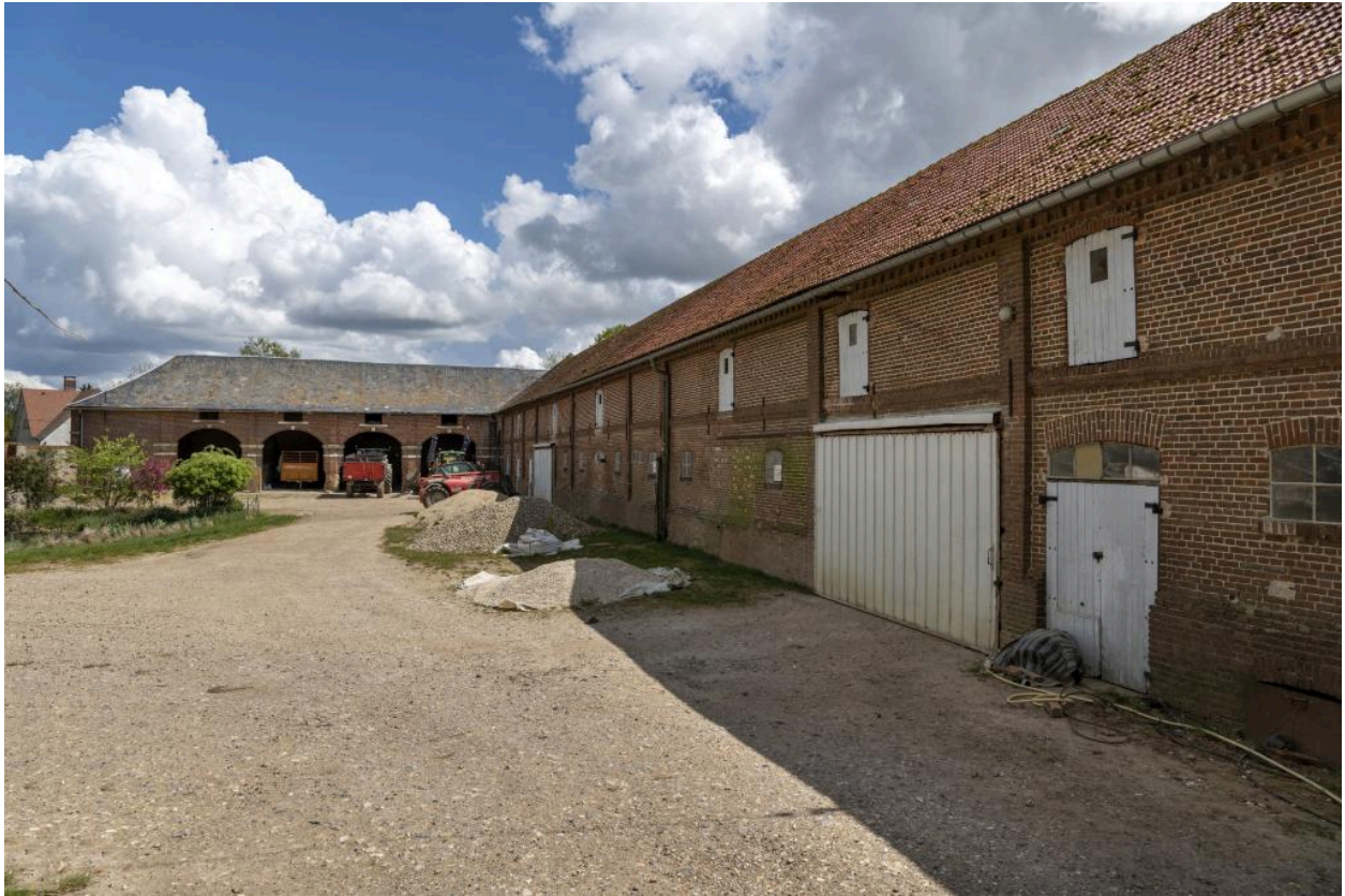
Anciennes étable et bergerie, surmontées d'un fenil, puis remises agricoles en retour, vue depuis l'ouest.
