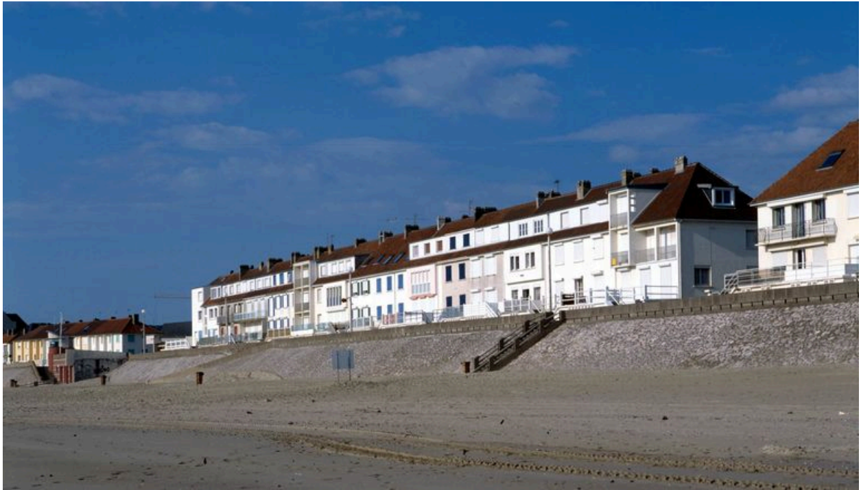
Le front de mer de Fort-Mahon-Plage : détail des maisons en bande de la digue sud.
