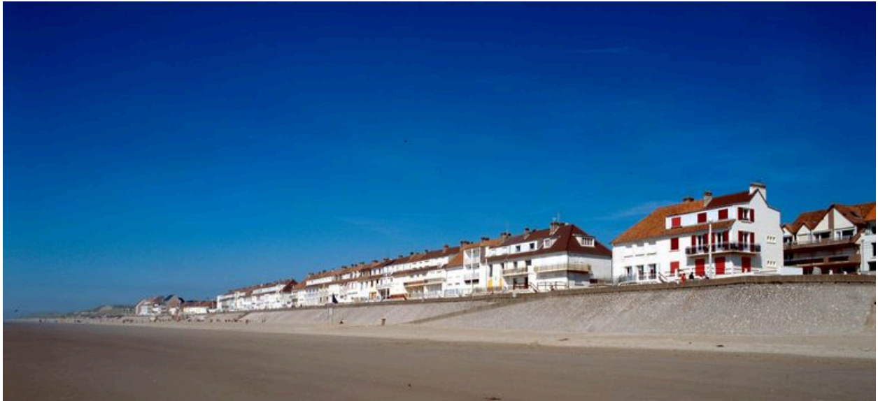
Le front de mer de Fort-Mahon-Plage : vue d'ensemble depuis la plage.
