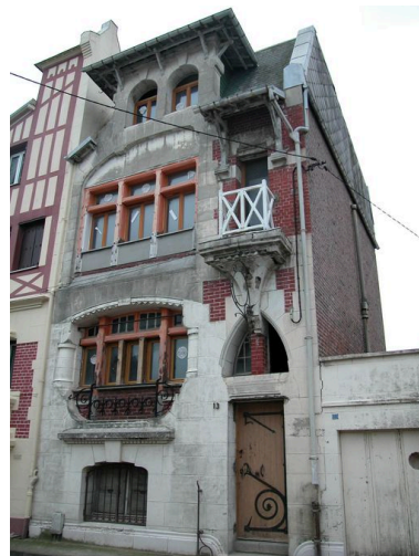
Détail de la maison de droite.
