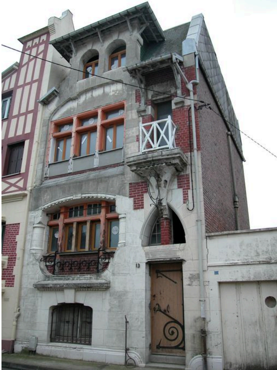
Détail de la maison de droite.
