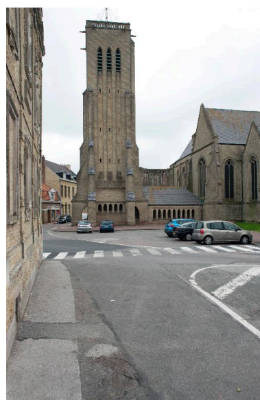
Vue générale de la tour clocher. Phot. Pierre Thibaut IVR31_20145903284NUCA
