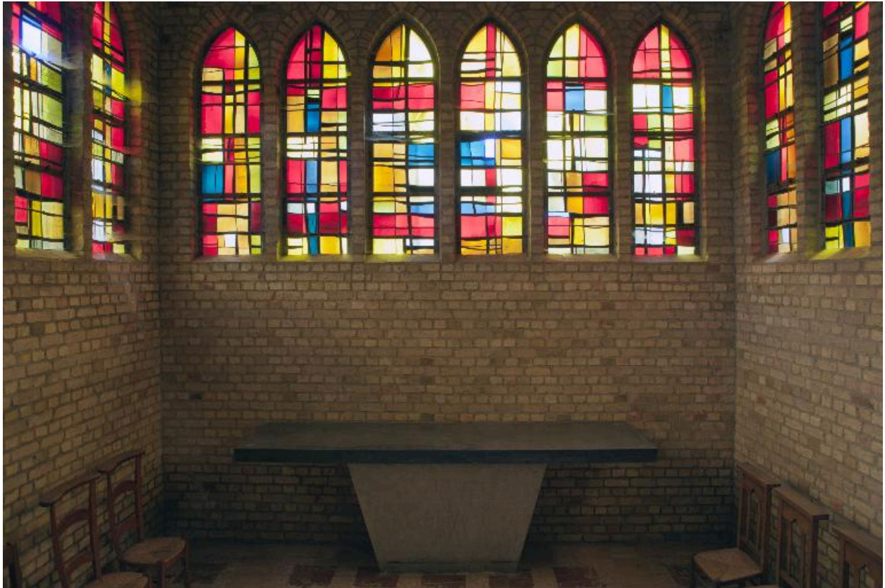
Chapelle hors-oeuvre ouvrant au nord de la nef.
