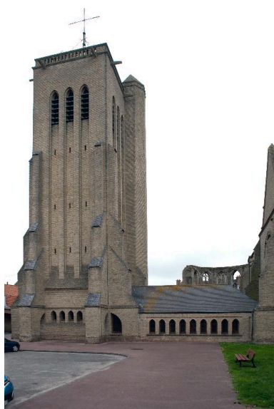
Vue générale de la tour clocher. Phot. Pierre Thibaut IVR31_20145903282NUCA
