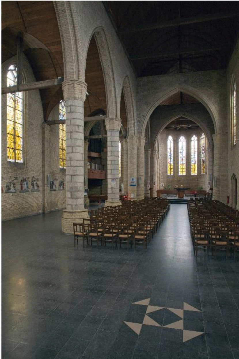
Vue de la nef et du collatéral nord.
