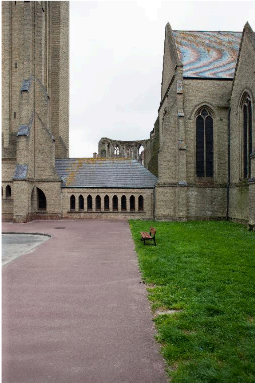
Vue générale du passage assurant la jonction de la tour à l'ancienne église.
