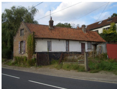
Vue de la façade orientale. Phot. Inès Guérin IVR22_20068005484NUCA
