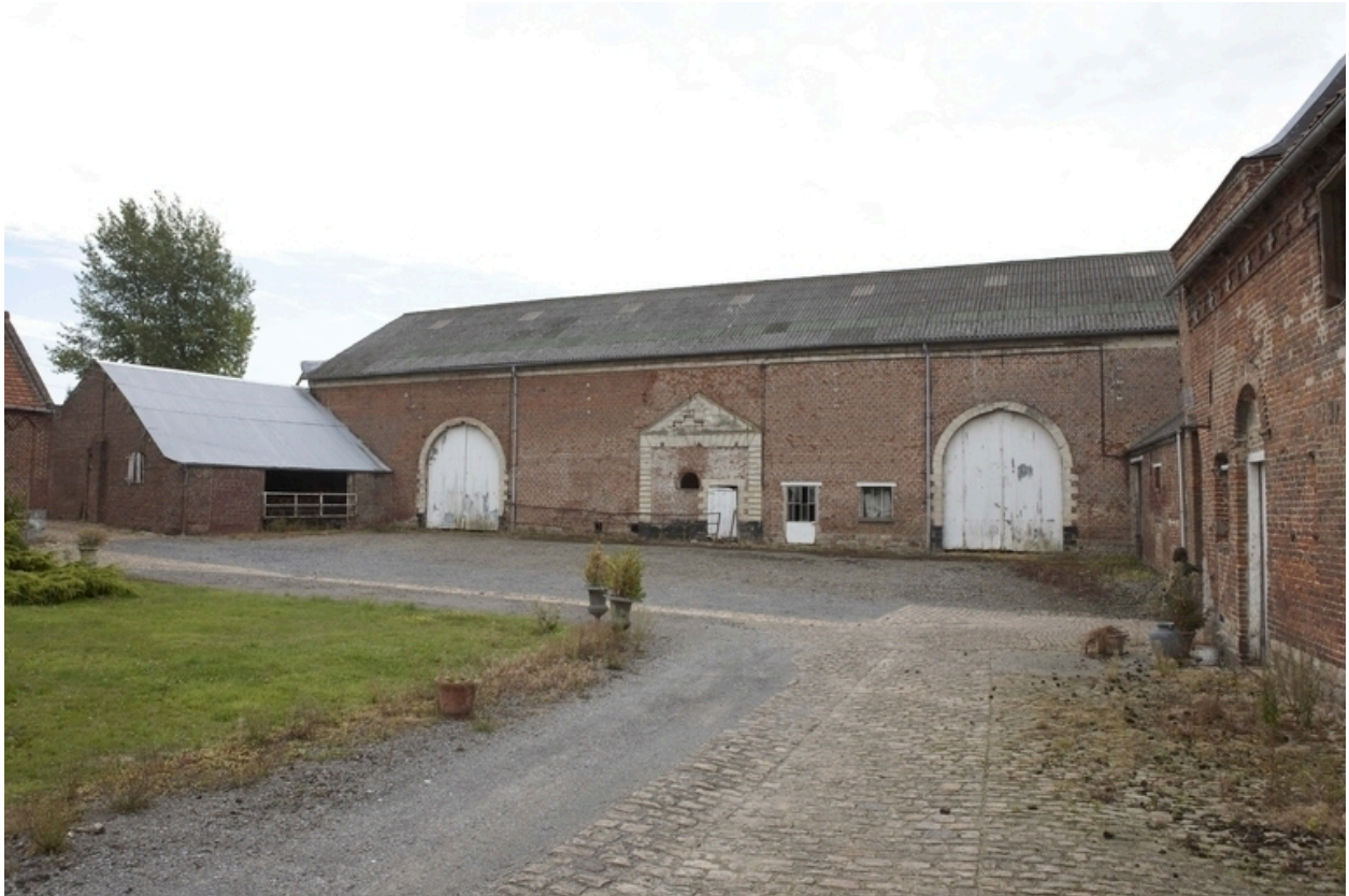
Vue de la grange-étable située au sud.
