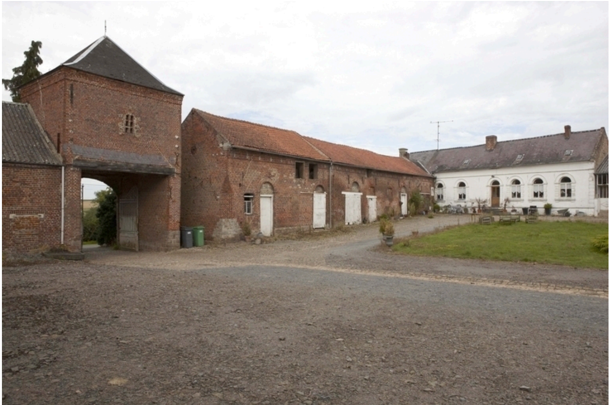
Vue du pigeonnier-porche, des écuries et du logis.
