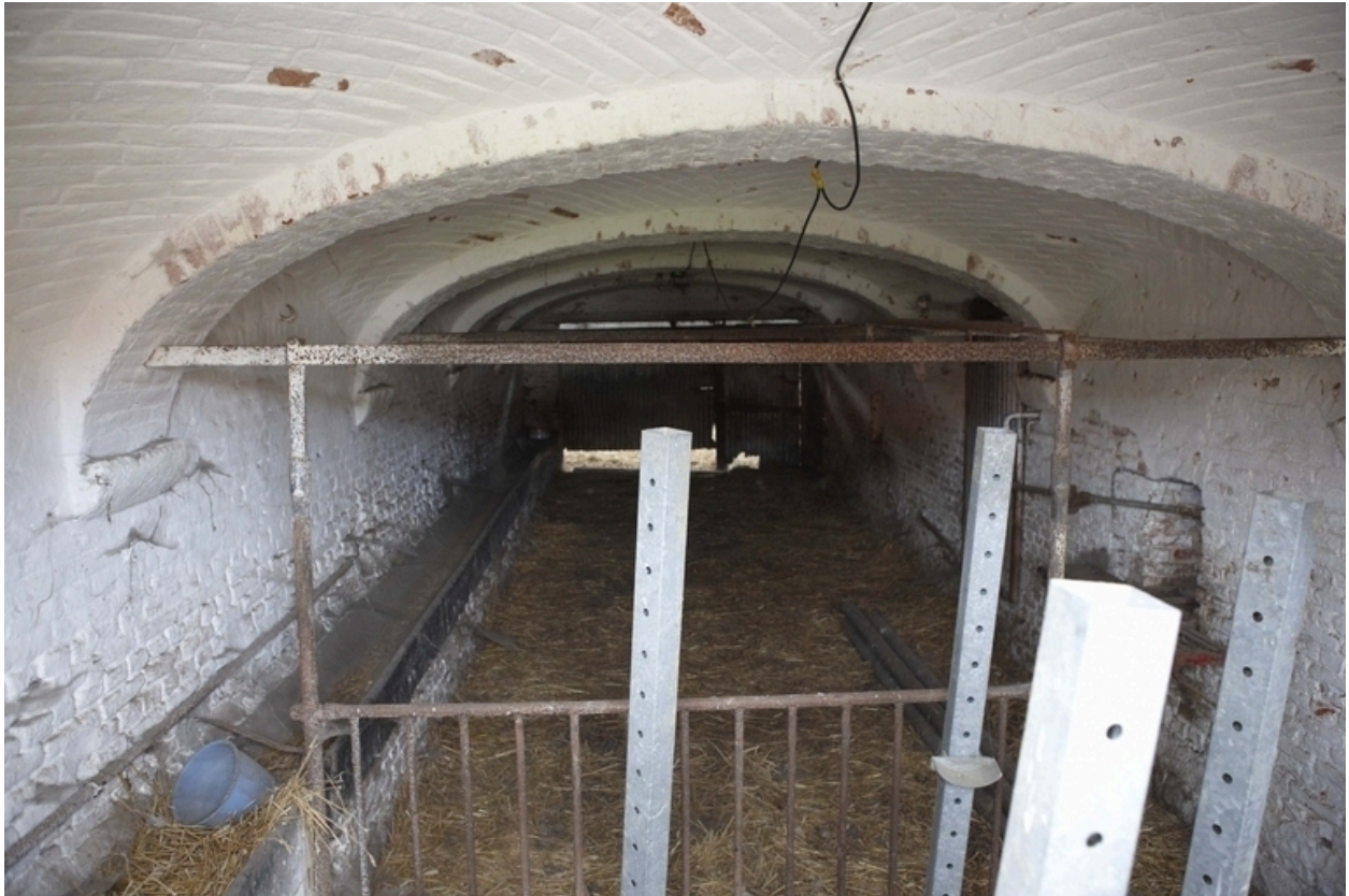
Vue de l'étable située derrière le fronton.
