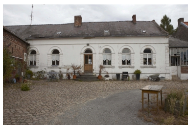
Vue de l'élévation sur cour du logis. Phot. Pierre Thibaut IVR31_20095902699NUCA
