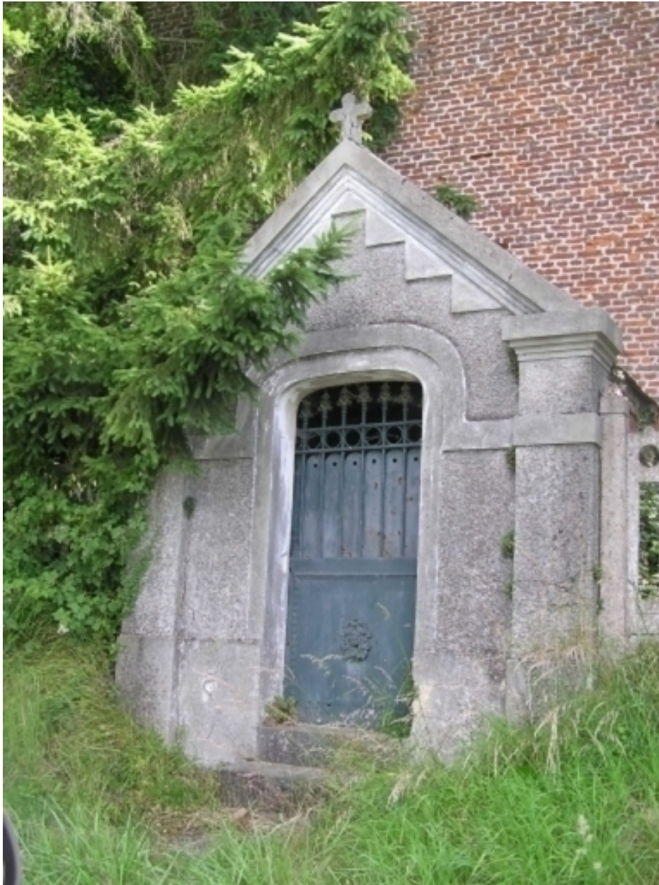
Vue de la chapelle Saint-Joseph située à l'extérieur de la ferme, le long du pigeonnier-porche et du bûcher.
