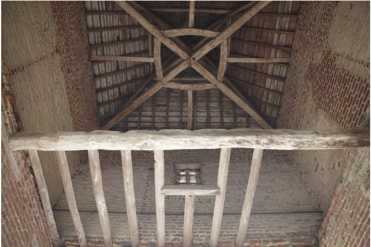
Détail de la voûte du pigeonnier-porche.
