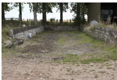
Vue d'un ancien abreuvoir, fosse à fumier ou espace de stockage indéterminé. Phot. Pierre Thibaut IVR31_20095902703NUCA
