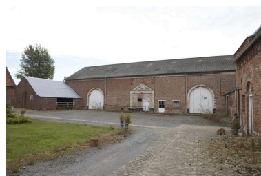
Vue de la grange-étable située au sud. Phot. Pierre Thibaut IVR31_20095902697NUCA
