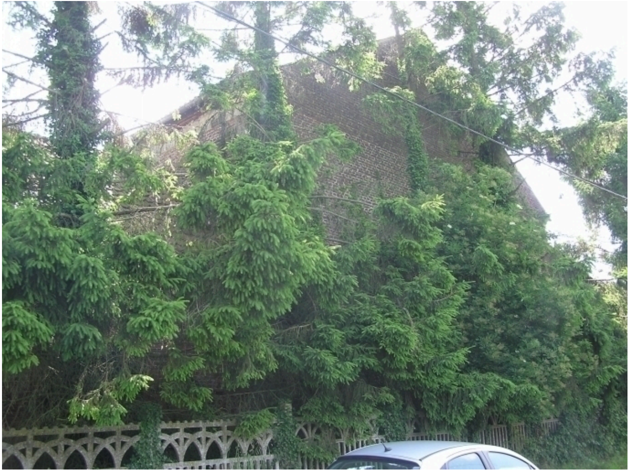
Vue d'un pignon de la grange.
