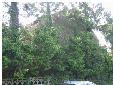
Vue d'un pignon de la grange. Phot. Raphaël Coipel IVR31_20095902309NUCA
