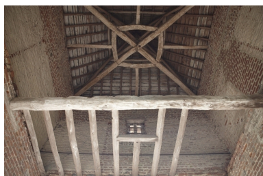
Détail de la voûte du pigeonnier-porche. Phot. Pierre Thibaut IVR31_20095902693NUCA
