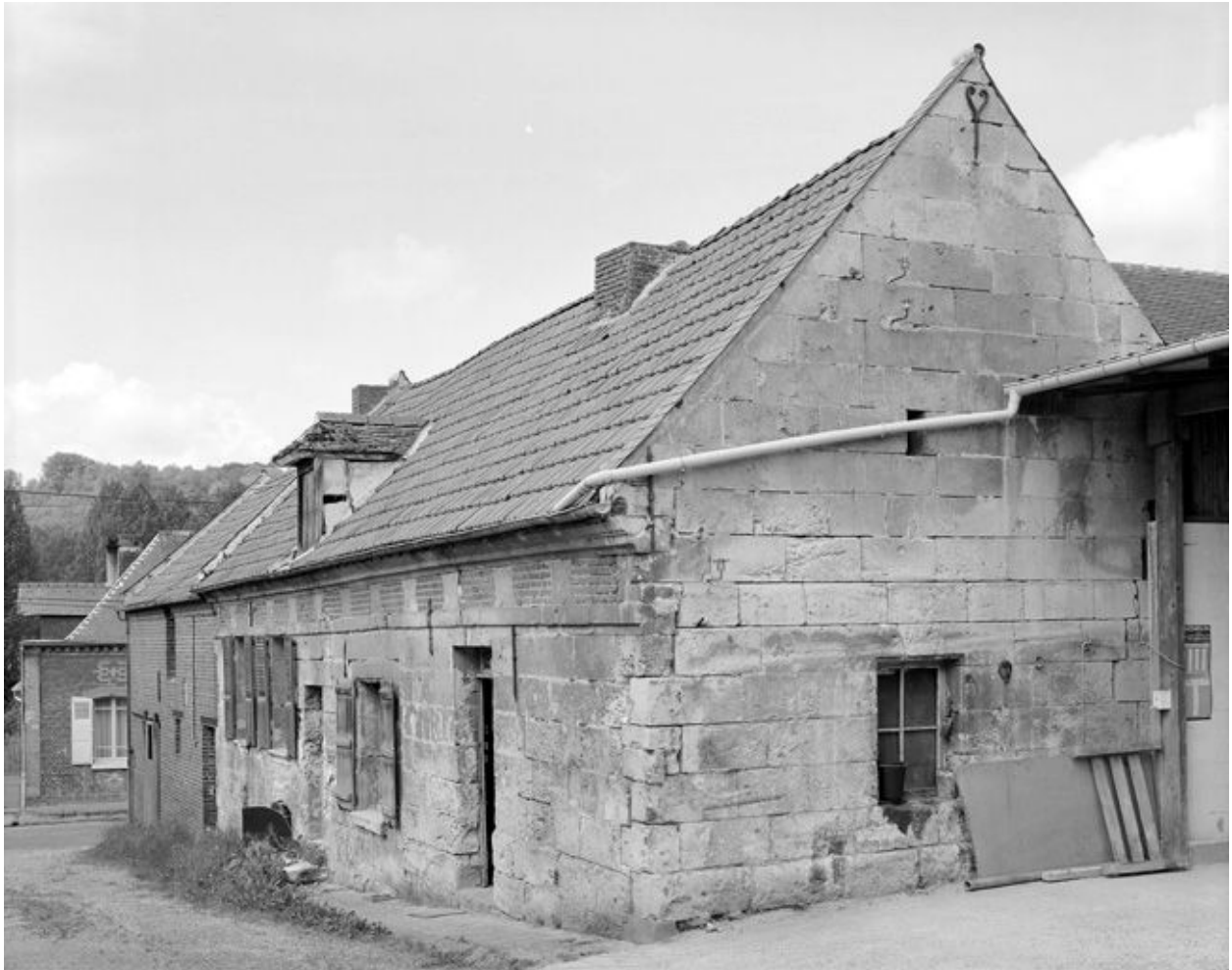
Logis. Élévation antérieure.
