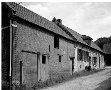
Etable à chevaux et logis. Vue générale. Phot. Jean-Michel Perrin IVR22_19856000846V
