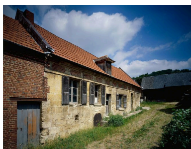
Logis. Elévation antérieure. Phot. Fabrice Charrondière IVR22_19866000161VA
