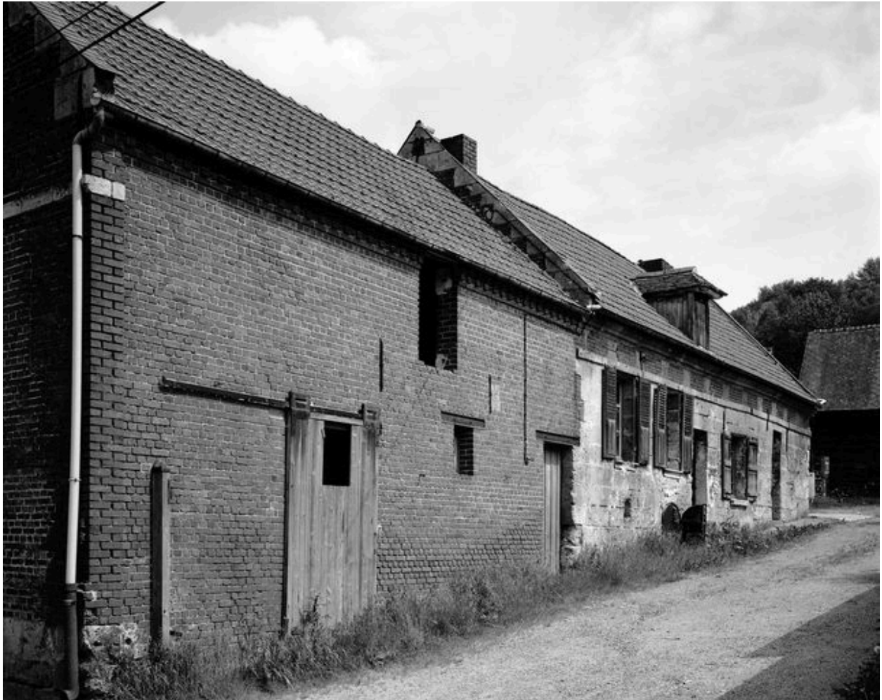
Etable à chevaux et logis. Vue générale.
