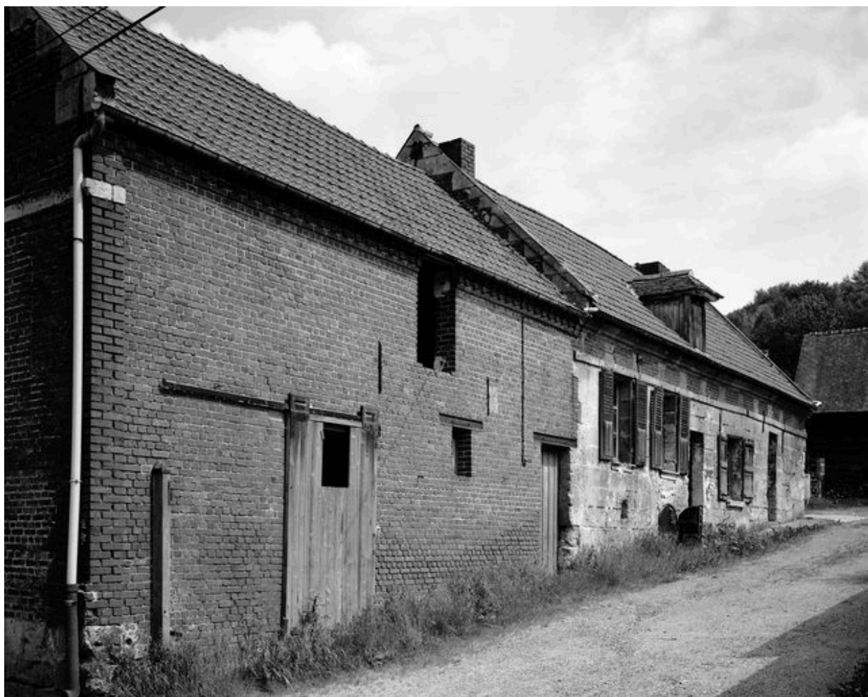
Etable à chevaux et logis. Vue générale.
