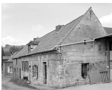
Logis. Elévation antérieure. Phot. Jean-Michel Perrin IVR22_19856000848V
