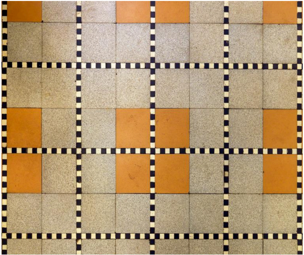
Détail du carrelage du préau.
