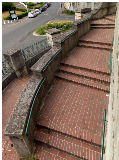
La rampe d'accès. Phot. Marie-Laure Monnehay-Vulliet IVR32_20186200222NUC2A
