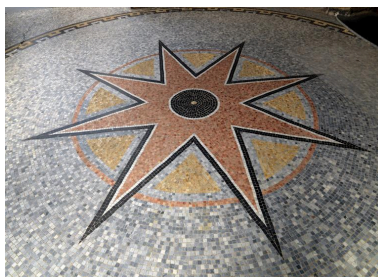
Détail du carrelage du porche. Phot. Marie-Laure Monnehay-Vulliet IVR32_20186200223NUC2A
