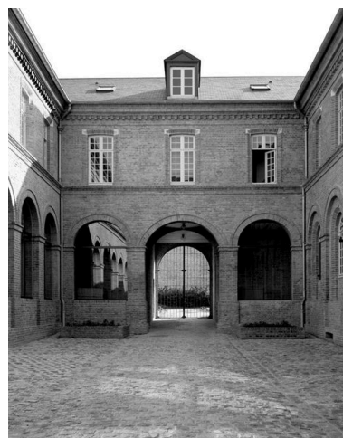
La cour dite des Provisions et le passage menant au jardin de l'infirmerie, en 1983. Les arcades de l'ancien cloître sont les seules conservées. Phot. Jean-Michel Périn IVR22_19838000023V
