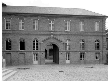
Façades sur la cour d'entrée, en 1983. A gauche du passage, les anciens parloirs. A droite du passage l'ancien ouvroir (rez-de-chaussée) et la salle du chapitre (au 1er étage), devenue salle de classe. Phot. Jean-Michel Périn IVR22_19838000005V
