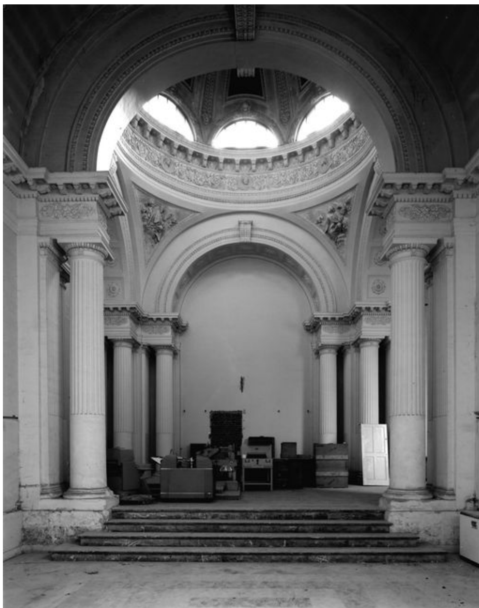
Chapelle, vue intérieure du chœur, en 1984.
