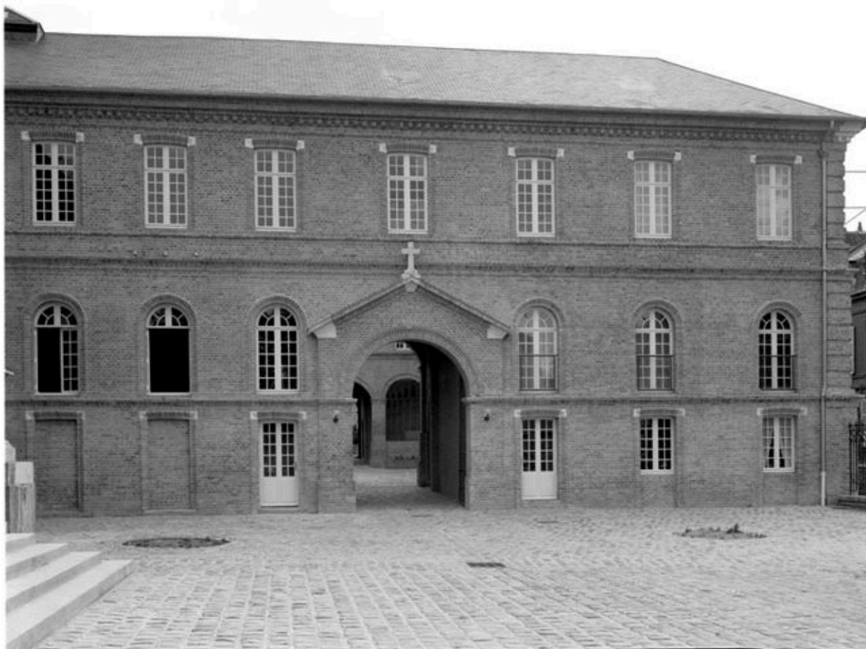
Façades sur la cour d'entrée, en 1983. A gauche du passage, les anciens parloirs. A droite du passage l'ancien ouvroir (rez-de-chaussée) et la salle du chapitre (au 1er étage), devenue salle de classe.
