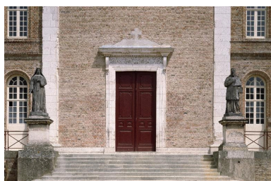
Vue de détail sur la façade de la chapelle. Phot. Jean-Michel Périn IVR22_19848000506XA
