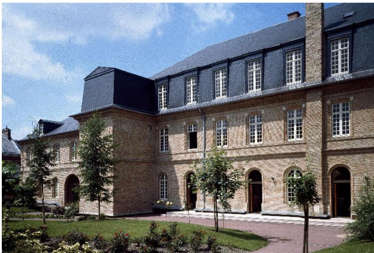
Façades sud sur l'ancien jardin des infirmeries, en 1984. Extension en retour construite vers 1980. Au premier plan, l'ancien réfectoire (rez-de-chaussée) et les dortoirs (étages).
