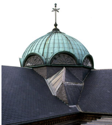
Chapelle. Détail sur la coupole, en 1987. Phot. Jean-Michel Périn IVR22_19878000358ZA
