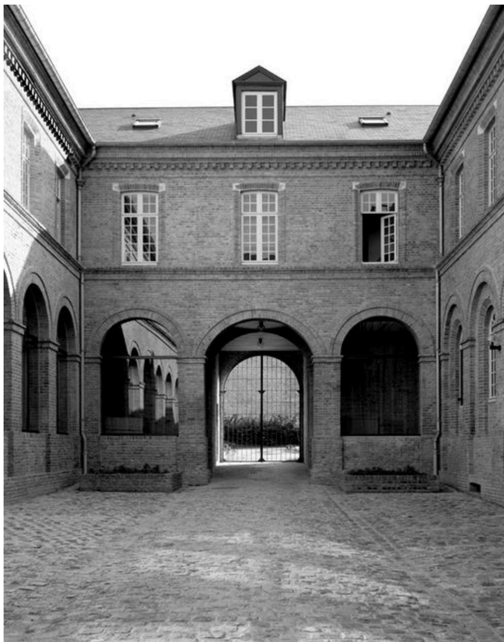
La cour dite des Provisions et le passage menant au jardin de l'infirmerie, en 1983. Les arcades de l'ancien cloître sont les seules conservées.
