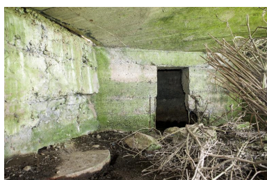
La chambre de tir, vers le nord. A gauche, le pas de tir et l'ouverture de tir condamnée. En face, l'accès à la soute à munition Phot. Jean-Marc Ramette IVR31_20145905545NUCA
