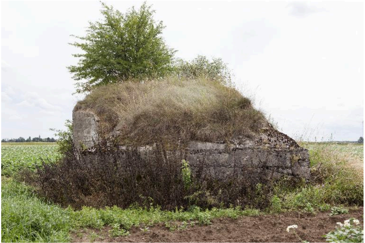
Vue latérale vers le sud
