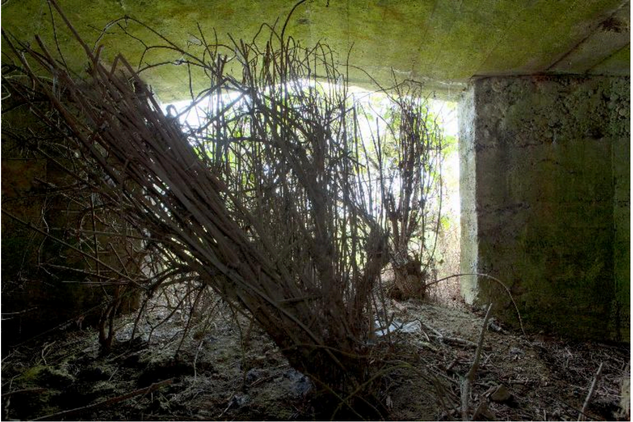
La chambre de tir, vers l'est
