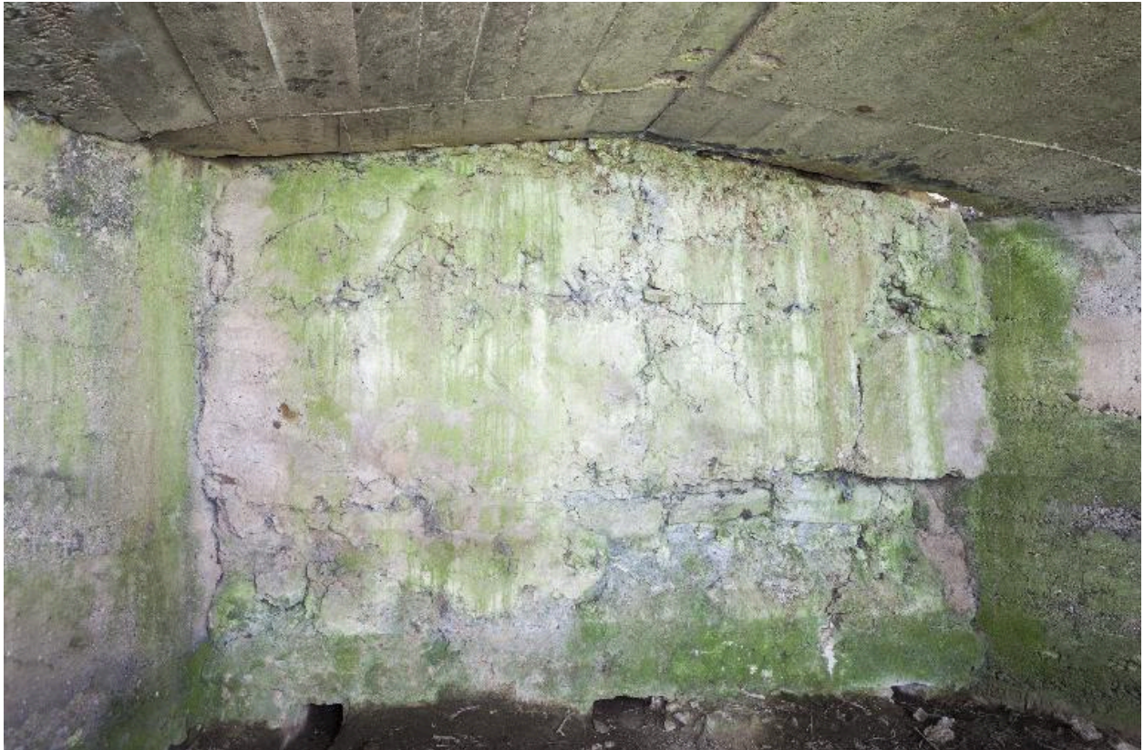
La chambre de tir et son ouverture murée
