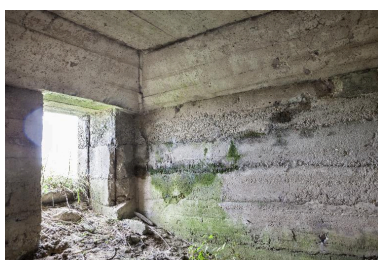
Soute à munition sud. Phot. Jean-Marc Ramette IVR31_20145905553NUCA
