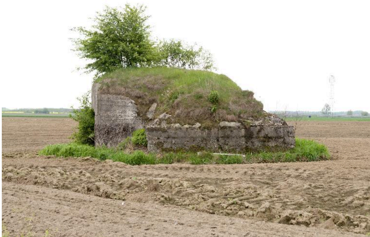
Vue latérale vers le sud
