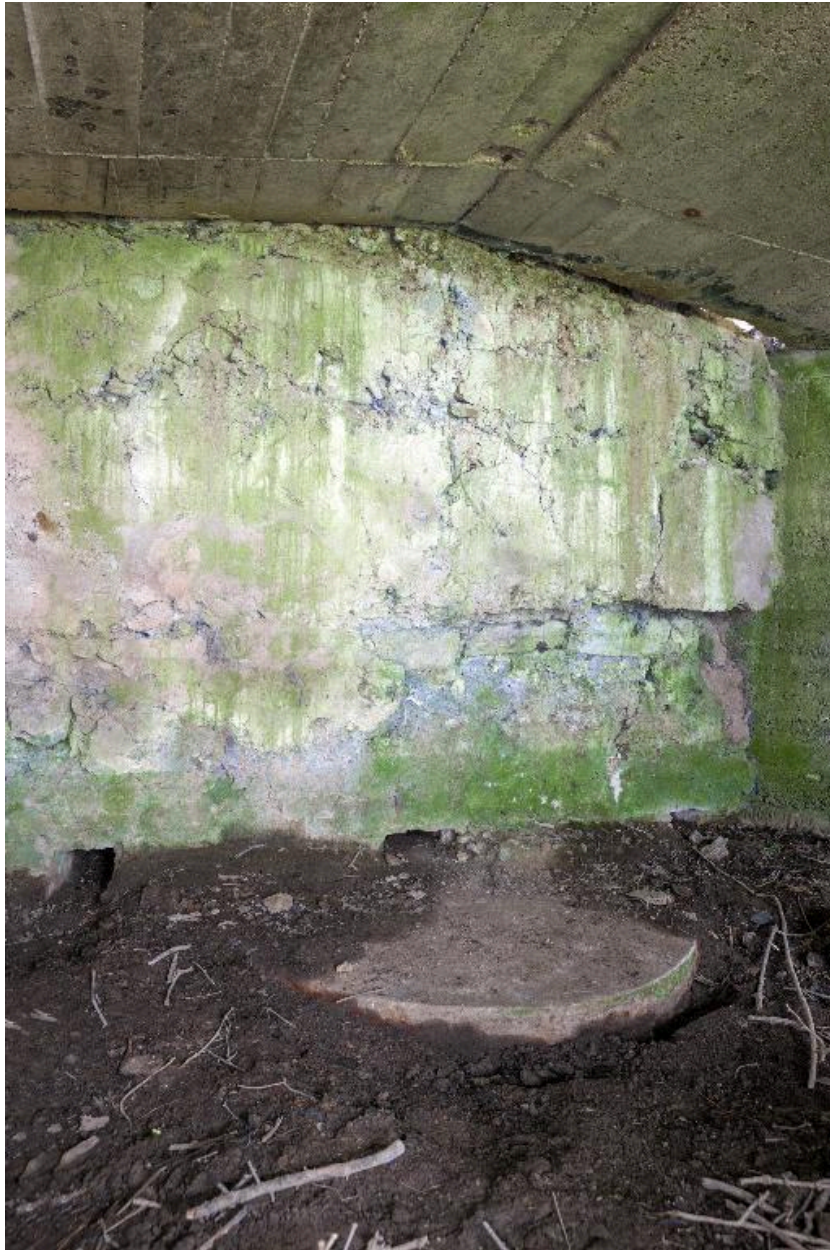
Chambre de tir, ouverture de tir condamnée
