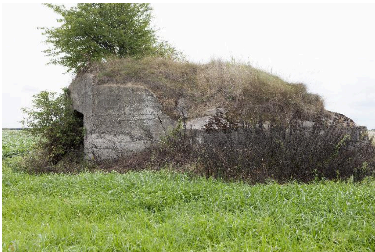
Vue latérale vers le sud
