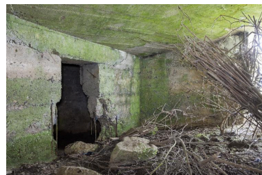
Depuis la chambre de tir, l'accès à la soute à munition nord. Phot. Jean-Marc Ramette IVR31_20145905550NUCA
