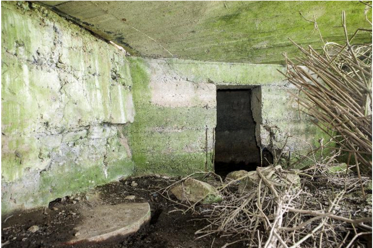
La chambre de tir, vers le nord. A gauche, le pas de tir et l'ouverture de tir condamnée. En face, l'accès à la soute à munition
