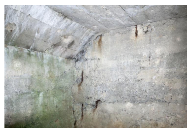
Couvrement de la soute à munition sud Phot. Jean-Marc Ramette IVR31_20145905546NUCA
