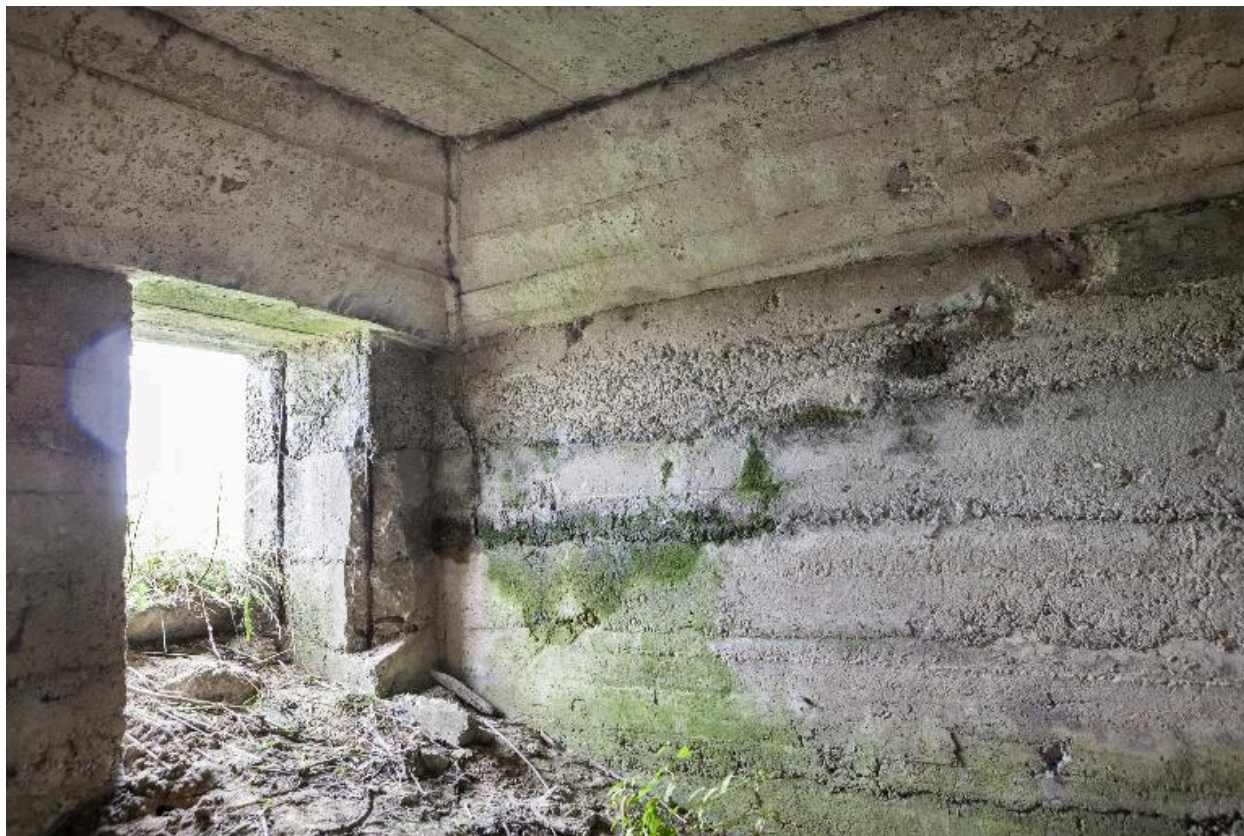
Soute à munition sud.
