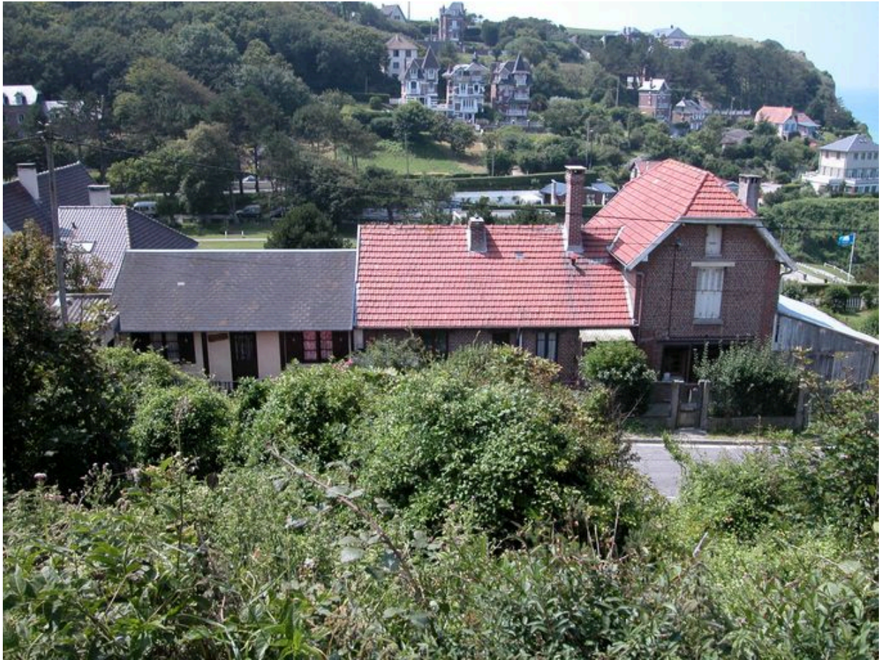
Elévation postérieure, vue depuis la routes des Mouettes.
