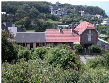
Elévation postérieure, vue depuis la routes des Mouettes. Phot. Elisabeth Justome IVR22_20058003042NUCA
