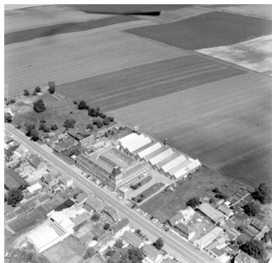
Vue aérienne, flanc sud-ouest. Phot. Phot'R IVR22_19888001262P
