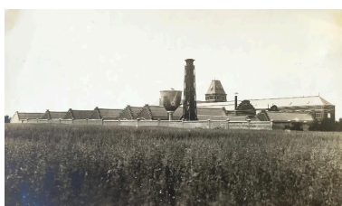
Vue d'ensemble nord-ouest de l'usine reconstruite. 1924 (AD Somme ; 10 R 1062). Phot. Fournier Bertrand (reproduction) IVR22_20158005129NUCA
