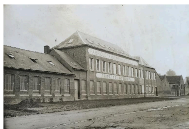
Façade sur rue de l'usine Tripette et Renaud Fils, état avant 1914. (AD Somme ; 10 R 1062). Phot. Fournier Bertrand (reproduction) IVR22_20158005111NUCA
