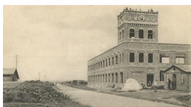
L'usine Tripette et Renaud en cours de construction, 1920 (Archives privées). Phot. Fournier Bertrand (reproduction) IVR22_20158005107NUCA
