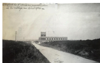
Bâtiment principal côté sud vers la route. Aspect de l'usine en reconstruction. 30 août 1920 (AD Somme ; 10 R 1062).
