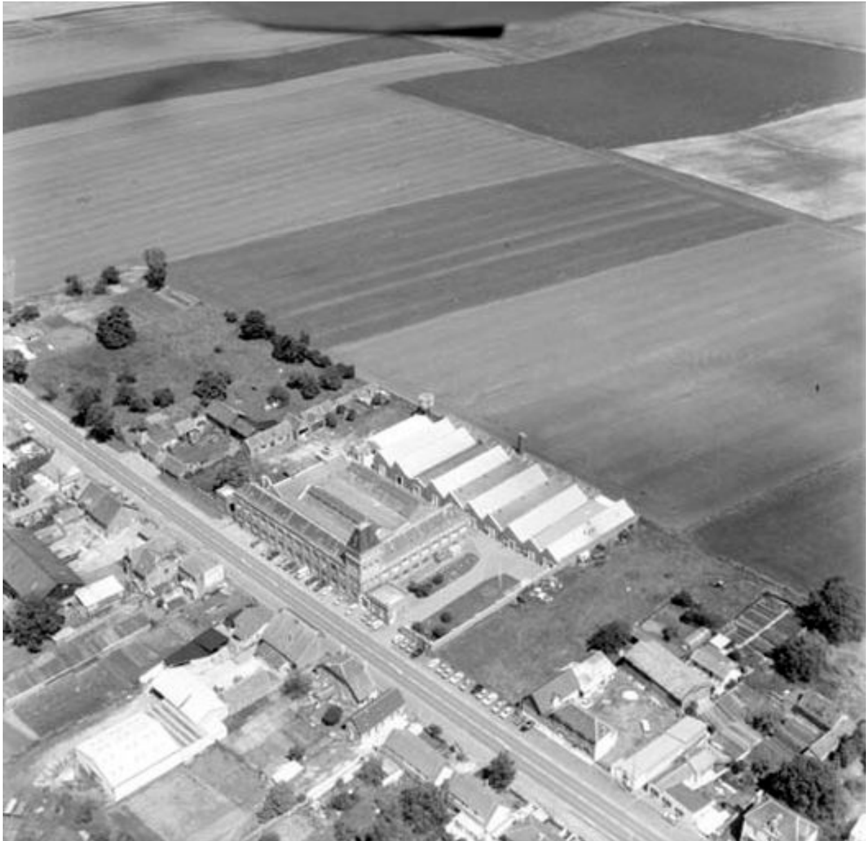
Vue aérienne, flanc sud-ouest.
