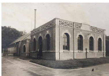
Chauffage et station centrale de force motrice (bâtiments 7, 15 et 21). 1914 (AD Somme 10 R 343). Phot. Fournier Bertrand (reproduction) IVR22_20158005126NUCA
