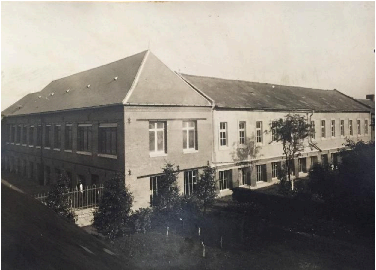
Vue d'ensemble de l'usine depuis le jardin, bâtiments est et sud en 1914. (AD Somme ; 10 R 343).
