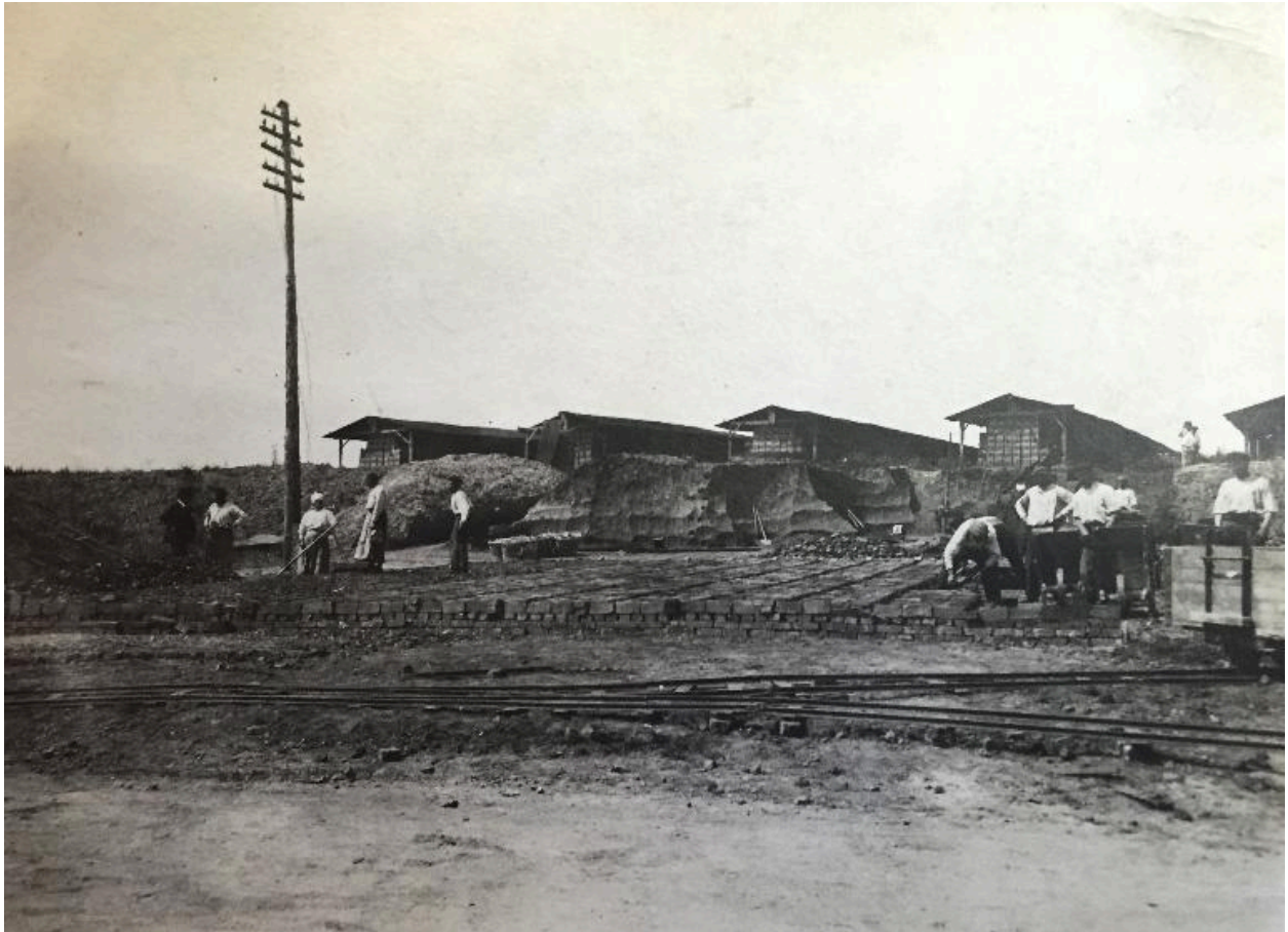
Les aires de séchage de la briqueterie implantée pour la reconstruction de la fabrique française de gazes à bluter, juin 1919 (AD Somme 10 R 343).
