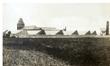
Vue d'ensemble sud-ouest de l'usine reconstruite. 1924. (AD Somme 10 R 1024). Phot. Fournier Bertrand (reproduction) IVR22_20158005130NUCA
