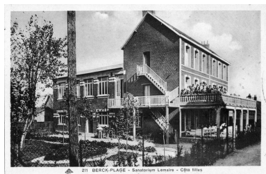
Bâtiment annexe ajouté dans les années 1920 pour les filles, élévation antérieure, vue générale prise de trois-quarts gauche. Carte postale, vers 1920-1930 (coll. part.). Phot. Stein Eddy IVR31_20076200003NUC
