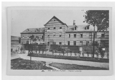
Hôpital Lemaire. Elévation antérieure, vue générale. Carte postale, début 20e siècle (coll. part.). Phot. Thierry Petitberghien (reproduction) IVR31_20046200281NUC
