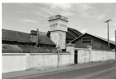
Le chateau d'eau depuis la rue Victor Hugo, en 1990. Phot. Francis Dubuc IVR22_19908000103Z
