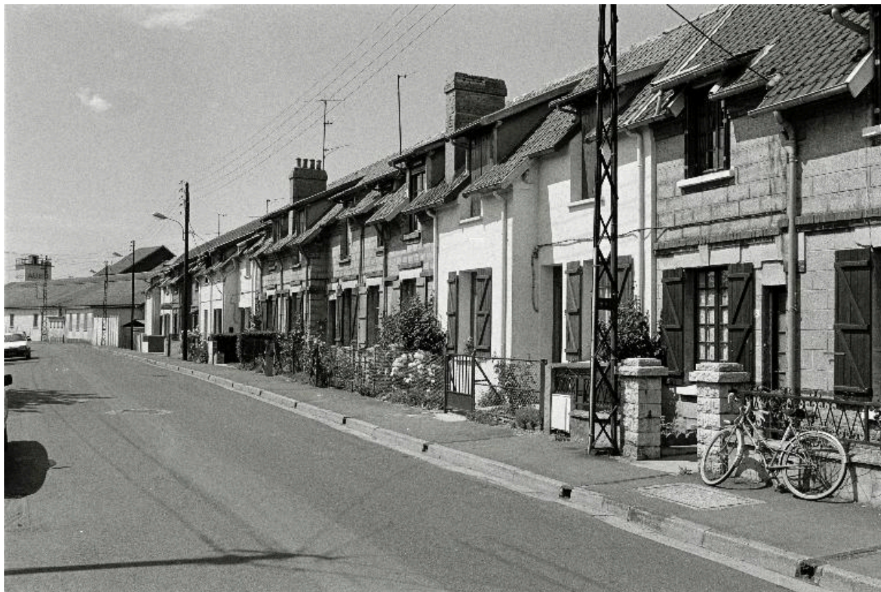
Vue général de la cité ouvrière, 2 à 20 rue Victor Hugo, en 1990.
