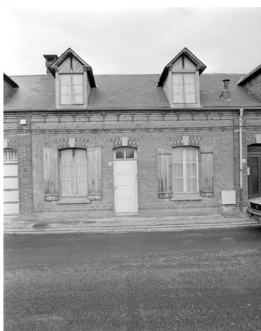
Logement d'ouvriers, détail, en 1988. Phot. Thierry Lefébure IVR22_19888000923X
