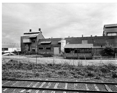
Vue partielle du site depuis le nord, en 1988. Phot. Thierry Lefébure IVR22_19888001649Z
