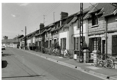
Vue général de la cité ouvrière, 2 à 20 rue Victor Hugo, en 1990. Phot. Francis Dubuc IVR22_19908000101Z
