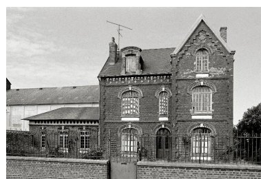
Logement patronal, en 1990. Phot. Francis Dubuc IVR22_19908000104Z
