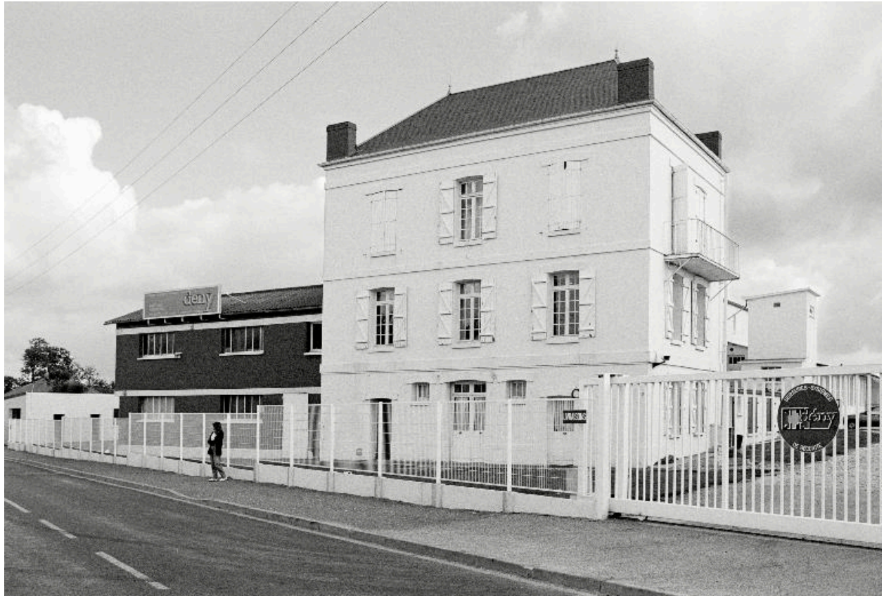
L'ancien logement du contremaître de l'usine, en 1990.
