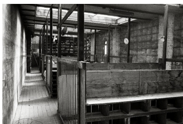
Vue intérieure de l'atelier de fabrication, en 1990. Phot. Francis Dubuc IVR22_19908000655Z
