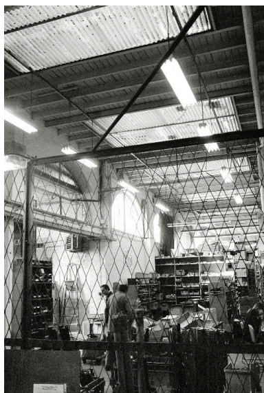
Vue intérieure de l'atelier de fabrication, en 1990. Phot. Francis Dubuc IVR22_19908000646Z
