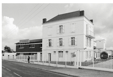
L'ancien logement du contremaître de l'usine, en 1990.
