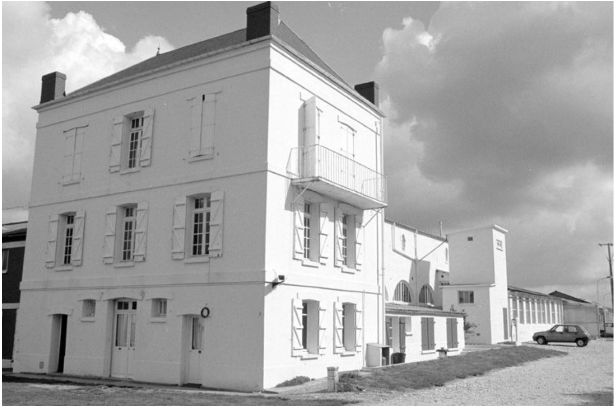
L'ancien logement du contremaître de l'usine, en 1990.
