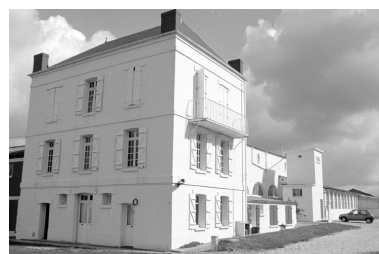
L'ancien logement du contremaître de l'usine, en 1990.
