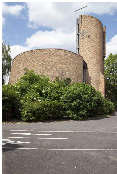
Élévation postérieure de l'église. Phot. Pierre Thibaut IVR31_20155900280NUCA
