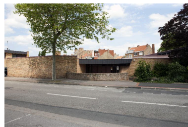
Élévation antérieure de l'église. Phot. Pierre Thibaut IVR31_20155900278NUCA
