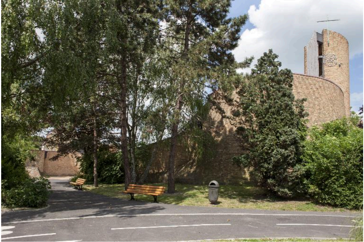
Élévation du flanc droit de l'église.
