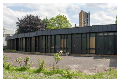
Élévation sur jardin, côté salle paroissiale. Phot. Pierre Thibaut IVR31_20155900283NUCA
