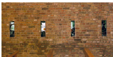
Vue des verrières côté droit. Phot. Pierre Thibaut IVR31_20155900290NUCA
