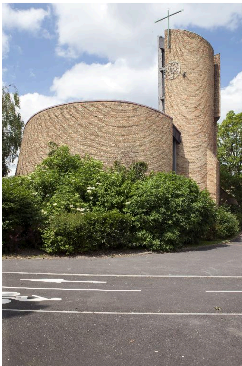
Élévation postérieure de l'église.
