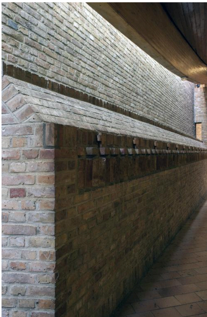
Vue du mur intérieur, du flanc gauche de l'église.
