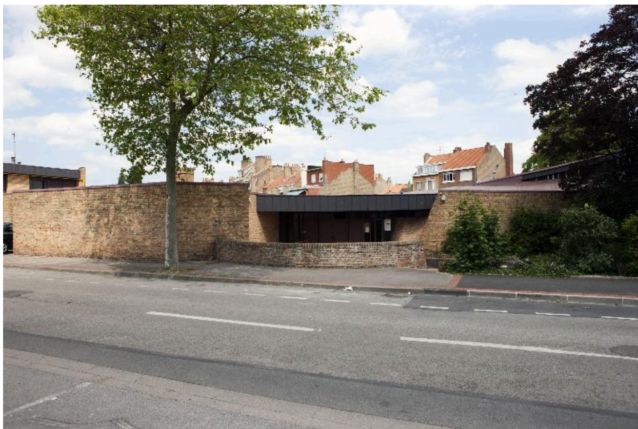
Élévation antérieure de l'église.
