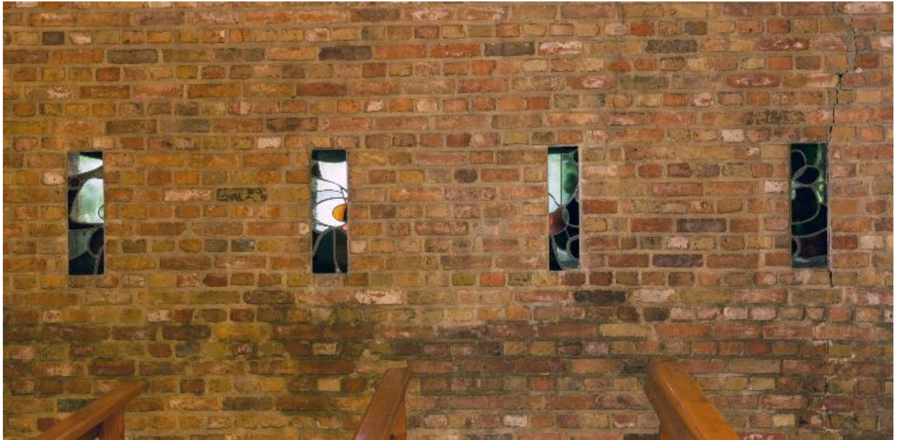
Vue des verrières côté droit.
