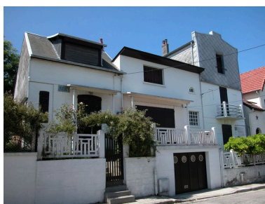
Maisons transformées, boulevard Carnot (AC 123, 124, 125). Phot. Elisabeth Justome IVR22_20058003358NUCA
