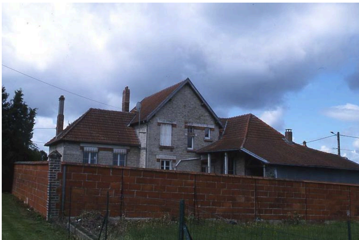
Vue postérieure de l'édifice.
