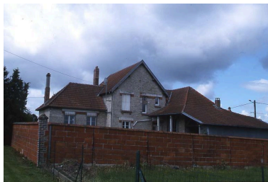
Vue postérieure de l'édifice. Phot. Inès Guérin IVR22_20030203187NUCA
