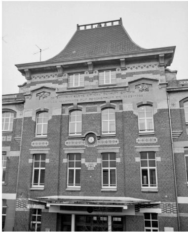
Détail du pavillon central de l'aile occidentale reconstruite en 1922 par l'architecte Jean Lafitte (1853-1928).
