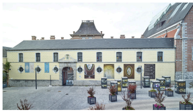
Vue de l'aile orientale depuis l'est. Phot. Pierre Thibaut IVR32_20225900808NUCA
