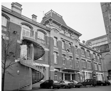
Vue de l'aile occidentale, reconstruite en 1922 par l'architecte Jean Lafitte (1853-1928). Phot. Thierry Petitberghien IVR31_20025900367X
