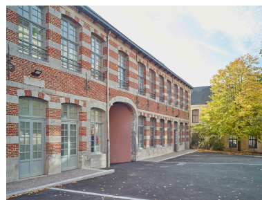
Vue de l'aile orientale, depuis la cour au nord-ouest. Phot. Pierre Thibaut IVR32_20225900780NUCA
