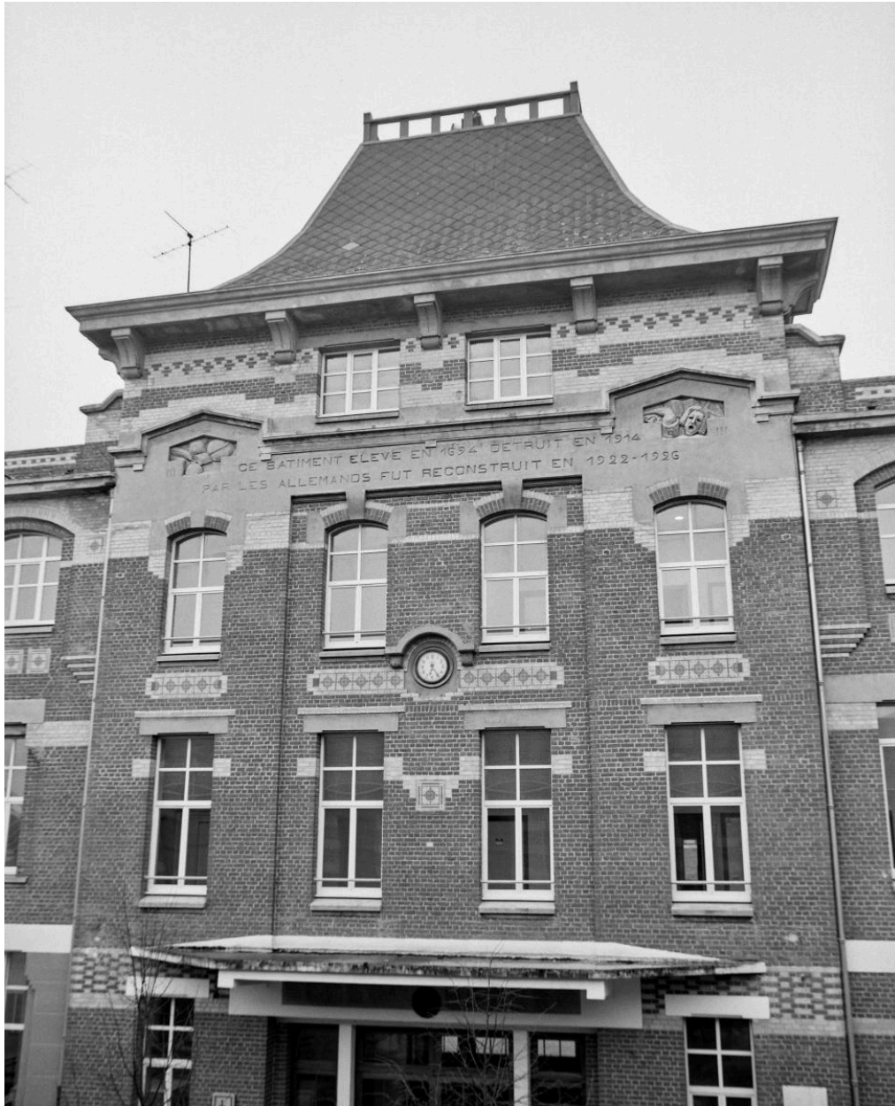
Détail du pavillon central de l'aile occidentale reconstruite en 1922 par l'architecte Jean Lafitte (1853-1928).
