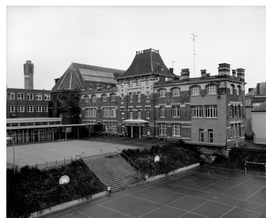
Vue de l'aile reconstruite en 1922 par l'architecte Jean Lafitte (1853-1928), depuis la cour du collège actuel à l'ouest. Phot. Thierry Petitberghien IVR31_20025900366X
