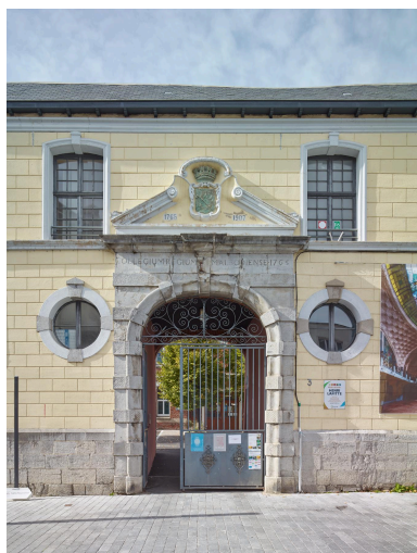
Vue du portail de l'aile orientale portant l'inscription "COLLEGIUM REGIUM MALBODIENSE 1765". Phot. Pierre Thibaut IVR32_20225900789NUCA
