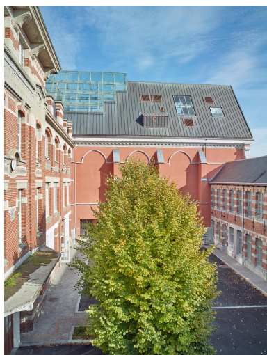
Vue depuis la cour au sud. Phot. Pierre Thibaut IVR32_20225900779NUCA
