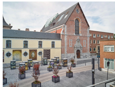
Vue depuis l'est de la chapelle du collège (actuelle salle Sthrau) dans le prolongement de l'aile orientale. Phot. Pierre Thibaut IVR32_20225900795NUCA
