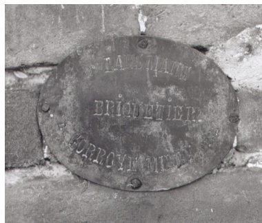
Plaque de la briqueterie sur le mur pignon de la grange. Phot. Thierry Lefébure IVR22_20026000862X
