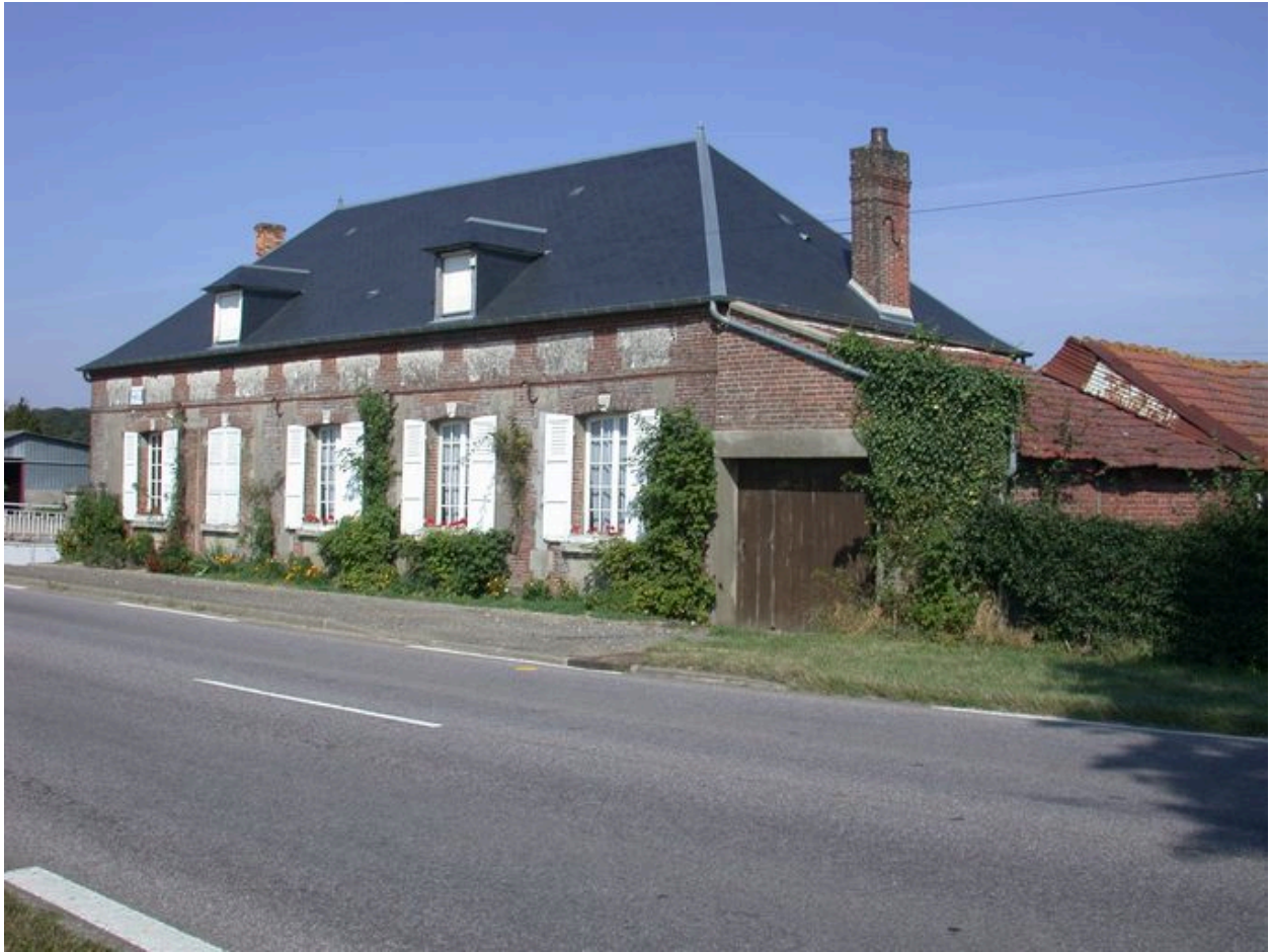
Vue générale du logement de briquetier.
