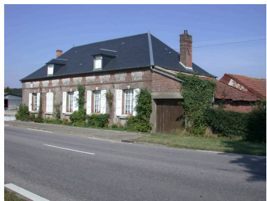
Vue générale du logement de briquetier. Phot. Thierry Lefébure IVR22_20026000872NUCA
