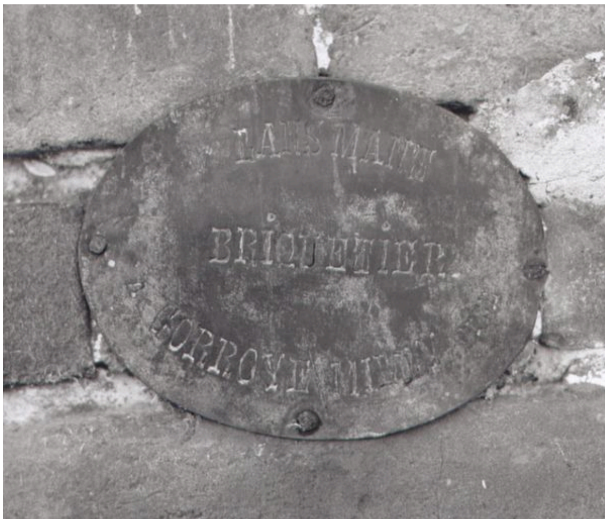
Plaque de la briqueterie sur le mur pignon de la grange.
