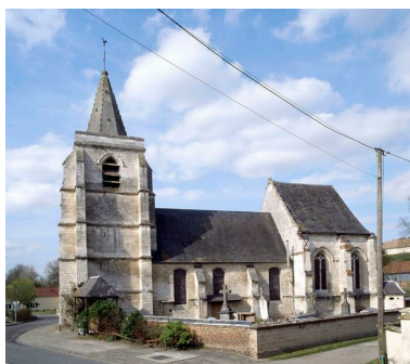
Franqueville, cimetière et église. Phot. Marie-Laure Monnehay-Vulliet IVR22_20108000126XA
