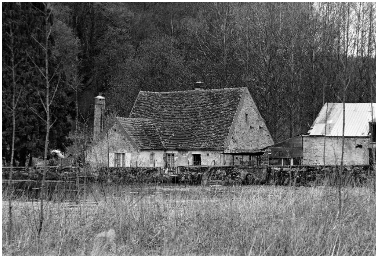
Le moulin, vu depuis l'ouest.
