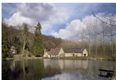
Vue générale du moulin, depuis l'étang. Phot. Fabrice Charrondièrre IVR22_19860200378XA
