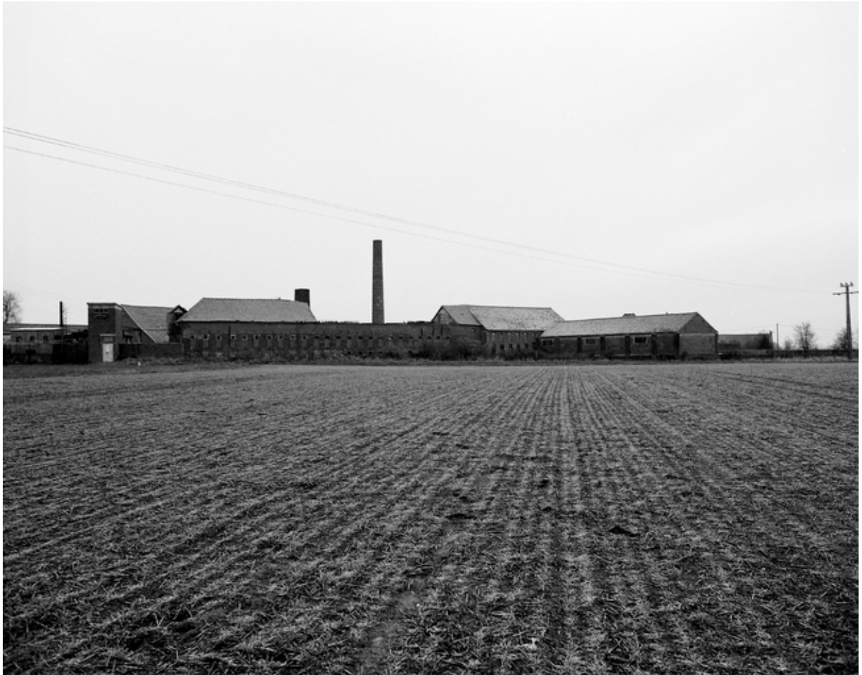
Paysage industriel ; la briqueterie-tuilerie de Beuvry-la-Forêt, rue H. Fivet.
