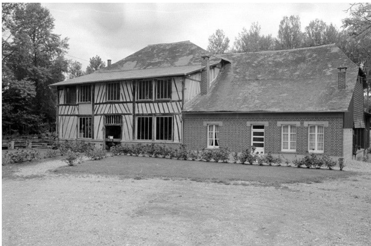
Atelier de fabrication, élévation antérieure.
