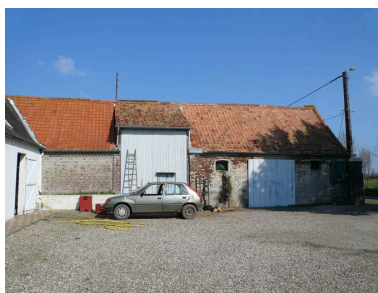
Vue de la grange depuis la cour. Phot. Inès Guérin IVR22_20078005508NUCA
