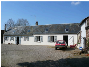
Vue du logis. Phot. Inès Guérin IVR22_20078005505NUCA
