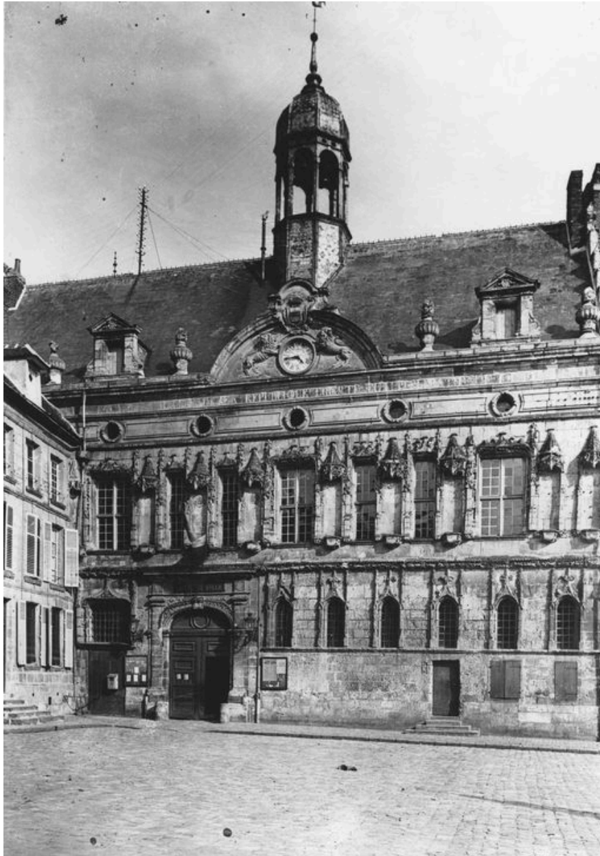
Vue générale de la façade, avant 1914 (AP).
