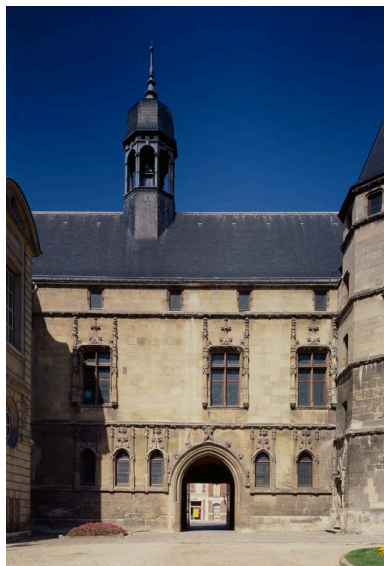
Elévation postérieure, détail. Phot. Fabrice Charrondière IVR22_19856001293XA
