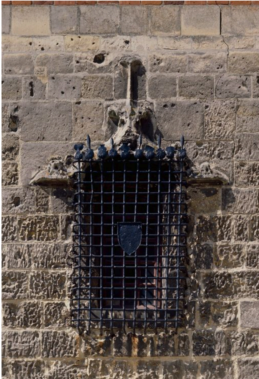
Détail de la baie avec la grille.
