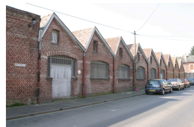
Les ateliers vus depuis la rue Pierre de Corbie. Phot. Frédéric Pillet IVR22_20070205183NUCA
