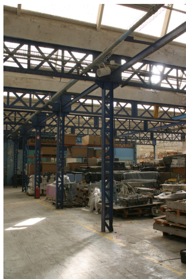
Vue inétrieure des ateliers. Phot. Frédéric Pillet IVR22_20070205185NUCA
