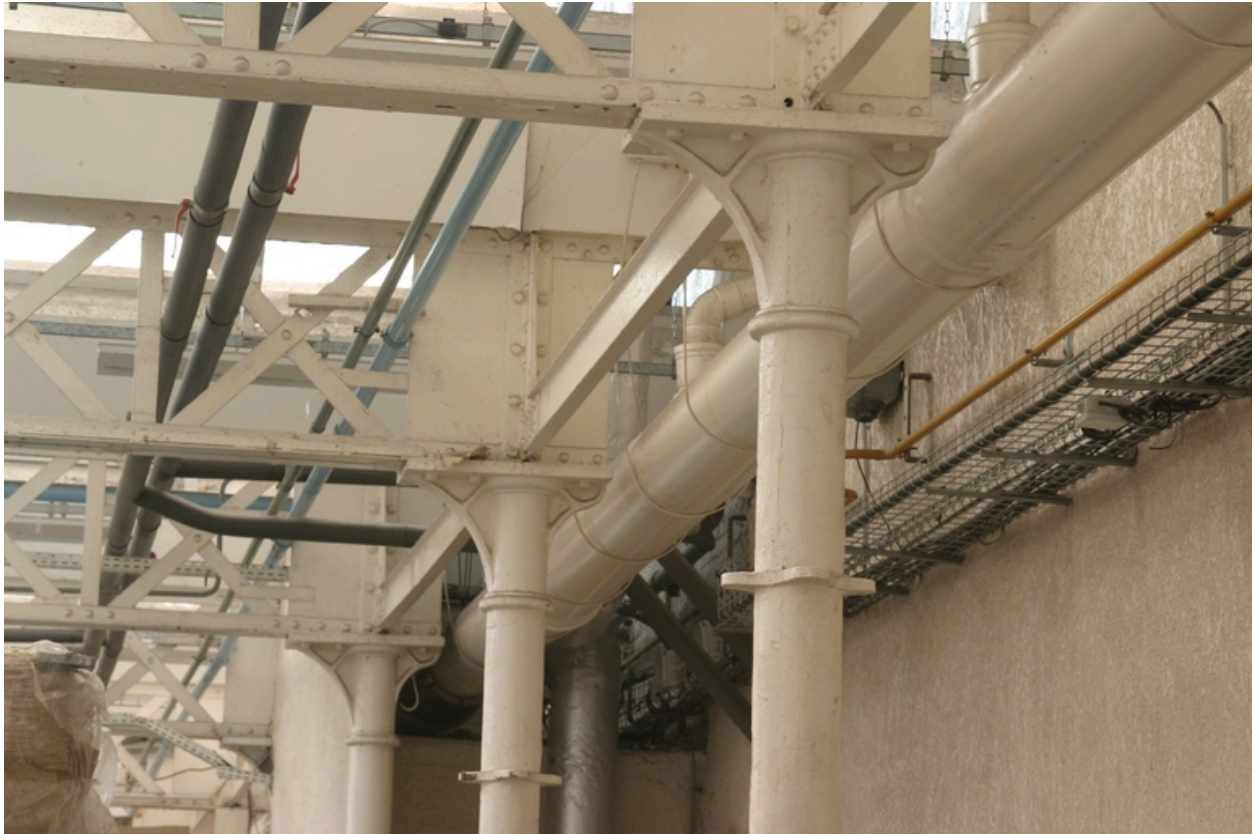
Vue intérieure des ateliers (réemploi de colonnes de fonte).
