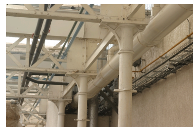
Vue intérieure des ateliers (réemploi de colonnes de fonte). Phot. Frédéric Pillet IVR22_20070205186NUCA
