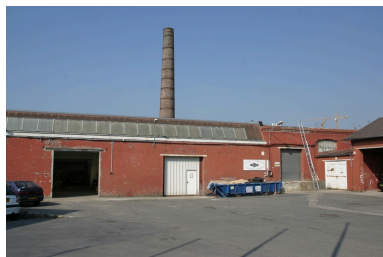
Ateliers et salle des machines ou chaufferie (à droite). Phot. Frédéric Pillet IVR22_20070205181NUCA
