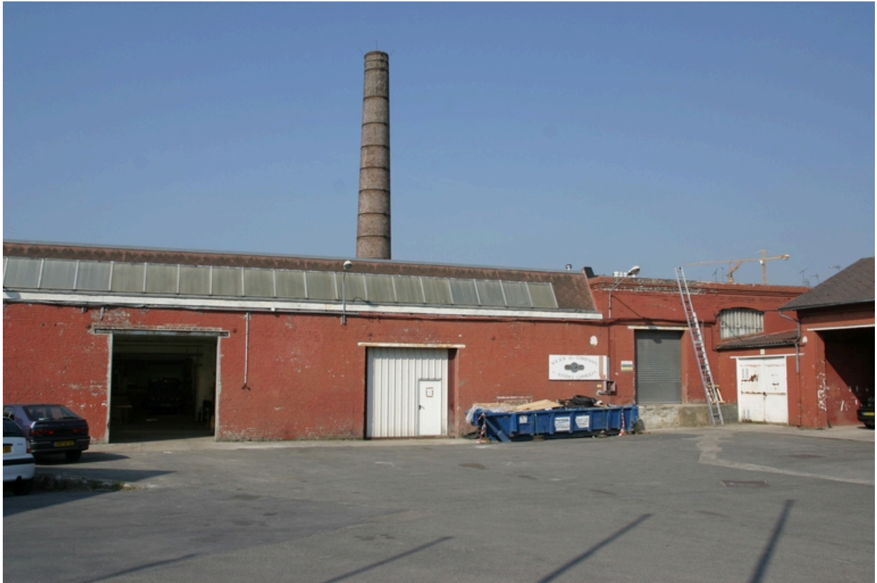
Ateliers et salle des machines ou chaufferie (à droite).
