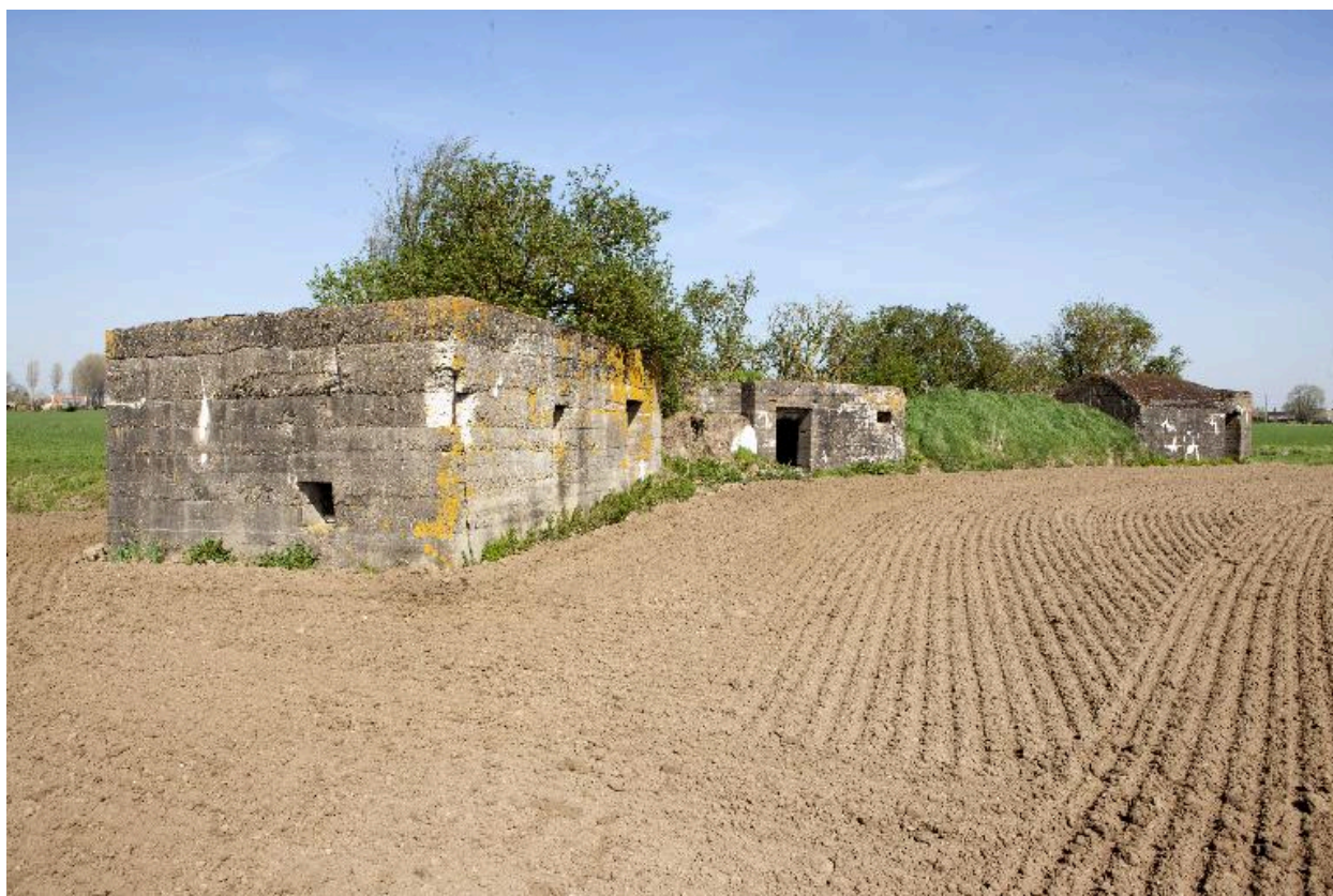
Vue d'ensemble vers le nord. De gauche à droite, les bâtiment 1, 2, (3) et 4
