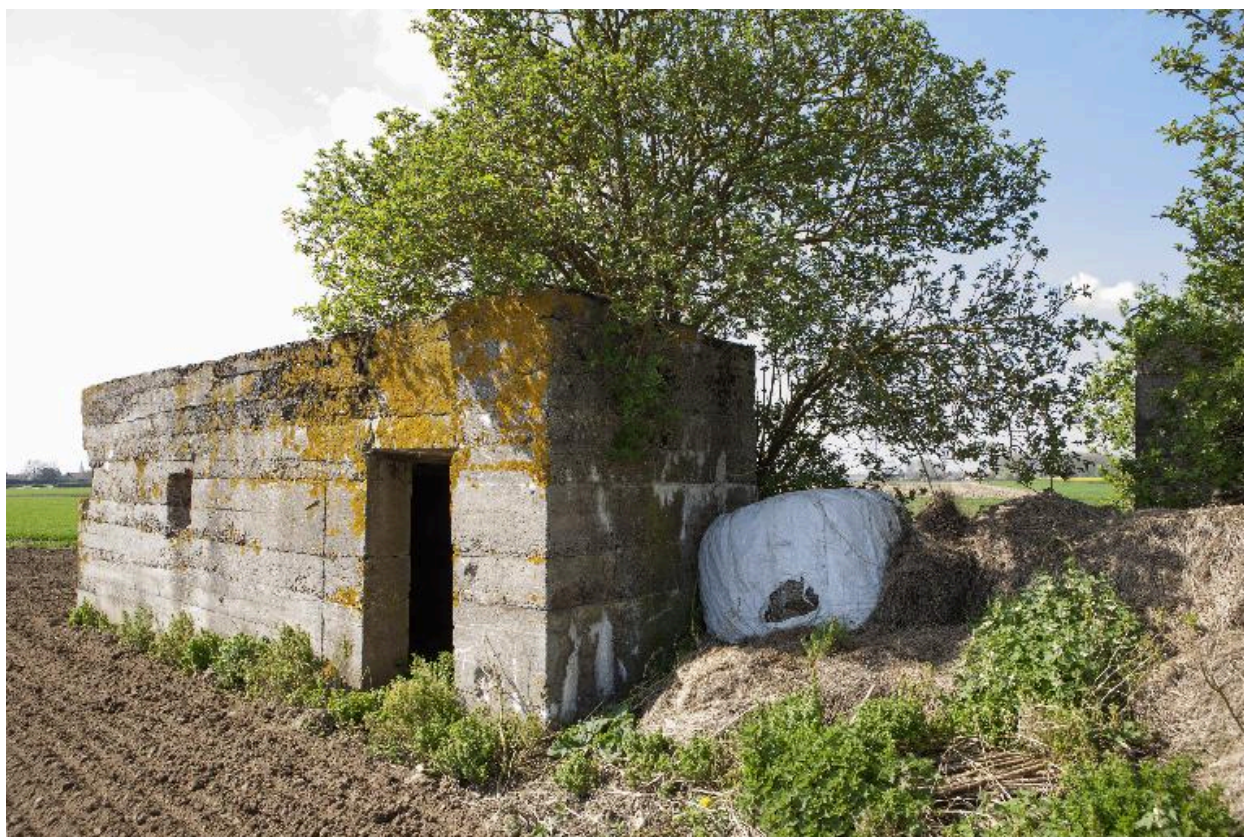
Bâtiment 1 : L'entrée sur élévation ouest
