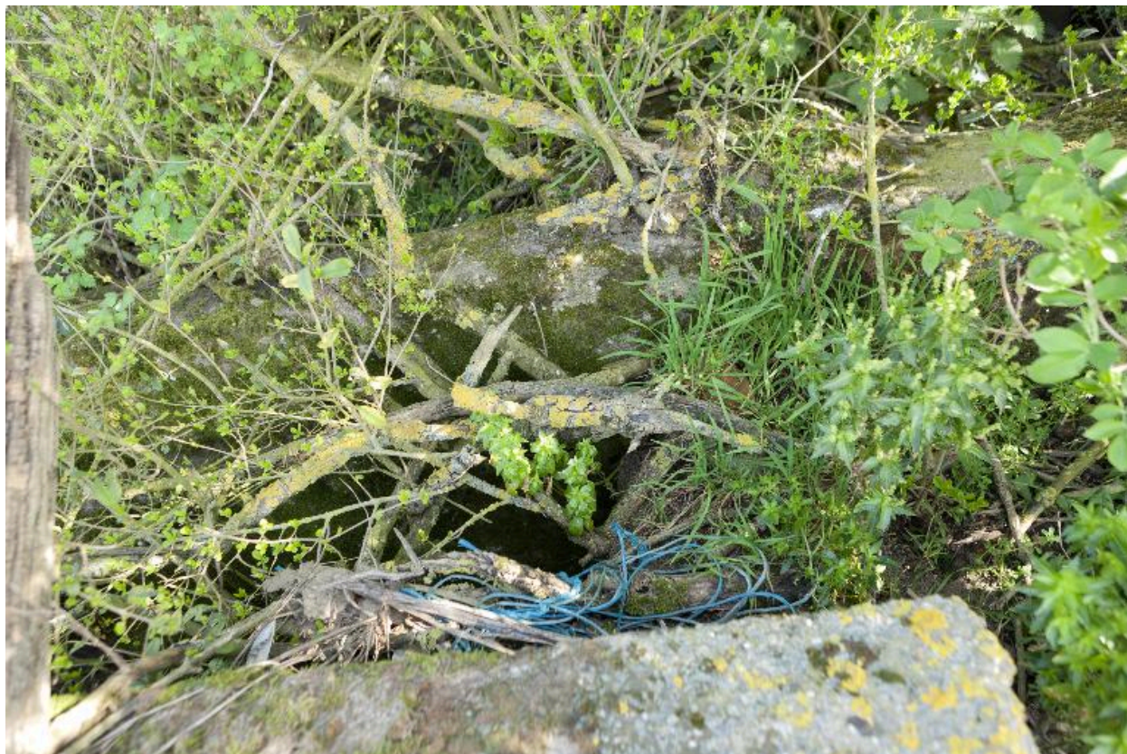
Rigole menant au bâtiment 1, partiellement découverte
