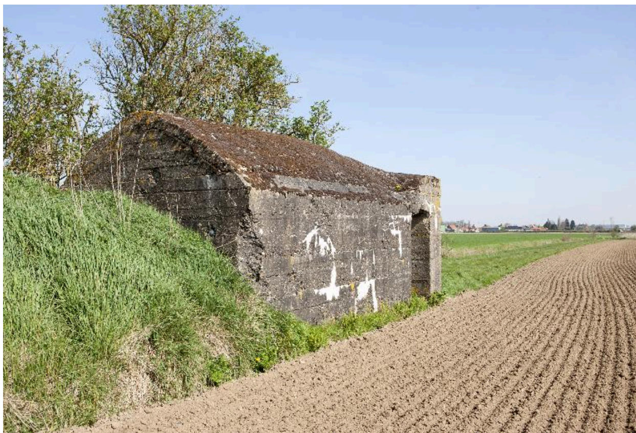
Bâtiment 4, élévation sud-est. A gauche le bâtiment 3 ?
