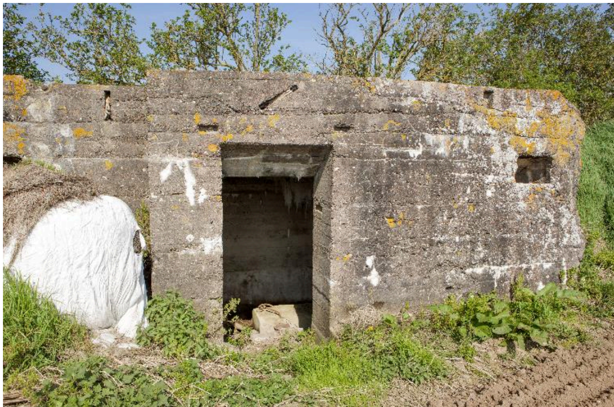
Bâtiment 2, élévation sud-est
