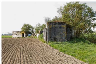
Vue d'ensemble vers le sud-ouest. Au premier plan le bâtiment 4 avec son entrée pare-souffle (?) Phot. Jean-Marc Ramette IVR31_20145905160NUCA
