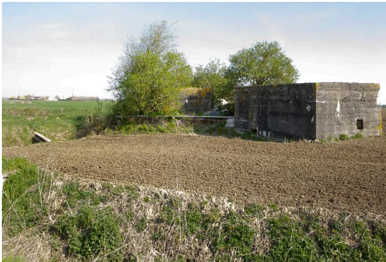
Vue postérieure de l'ensemble, vers le nord. A gauche, le ruisseau, au centre la rigole bétonnée.
