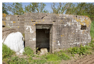
Bâtiment 2, élévation sud-est Phot. Jean-Marc Ramette IVR31_20145905162NUCA
