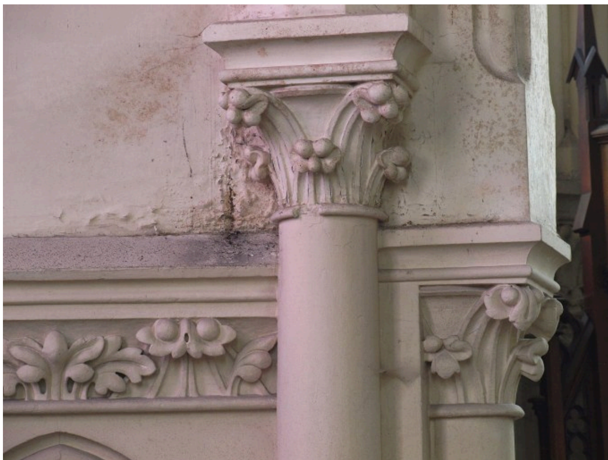
Chapelle, vue intérieure, détail, décor architectural
