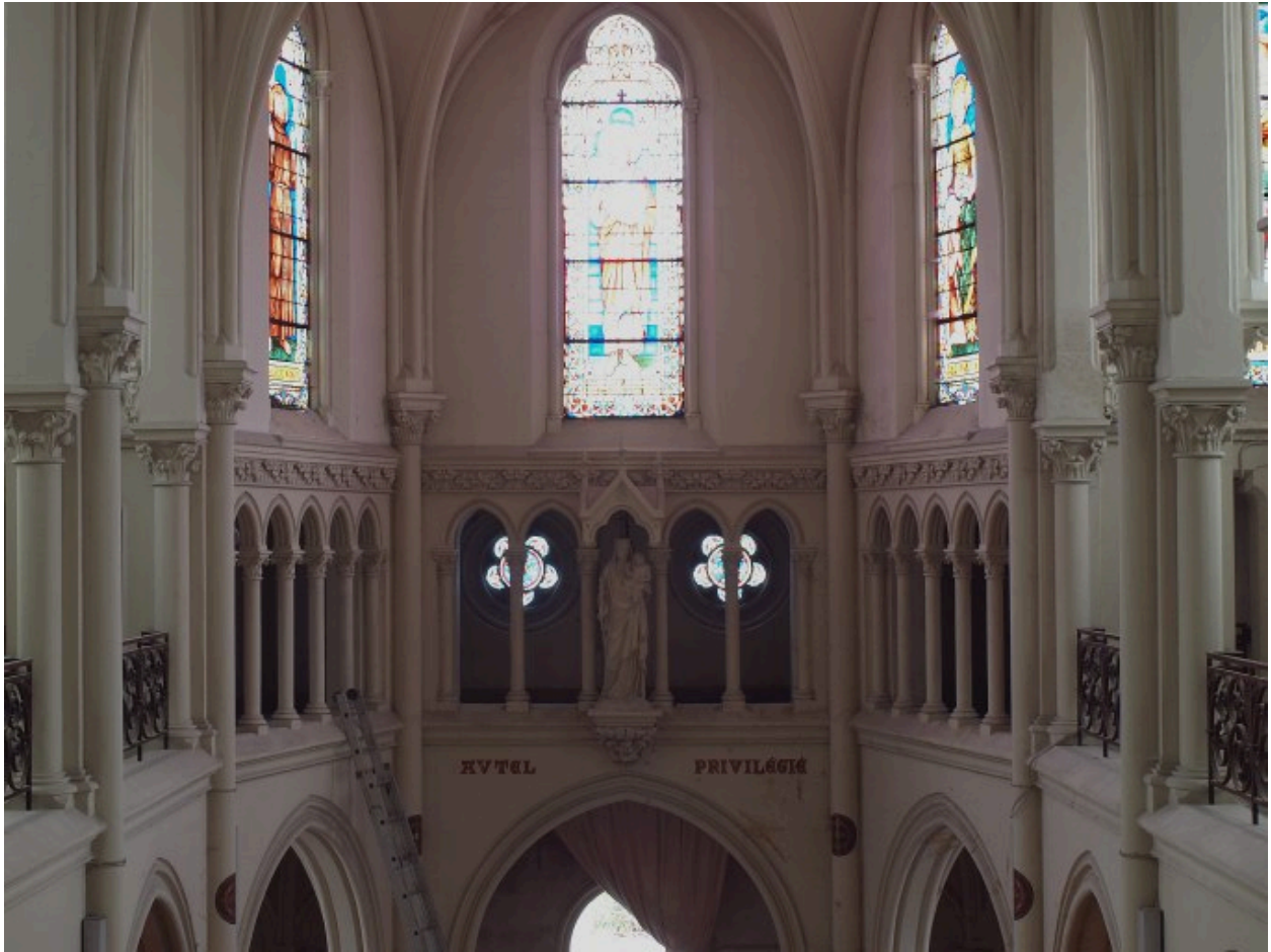
Chapelle, vue intérieure, niveau tribunes
