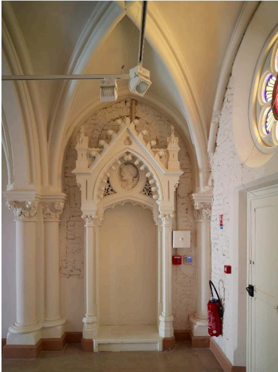
Vue d'un ancien confessionnal.
