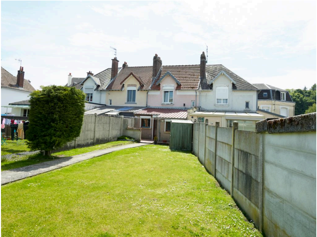
Groupe de quatre logements. Vue générale des façades arrières et des jardins des numéros 25 à 31 des maisons de la rue Marcellin Gaudefroy.
