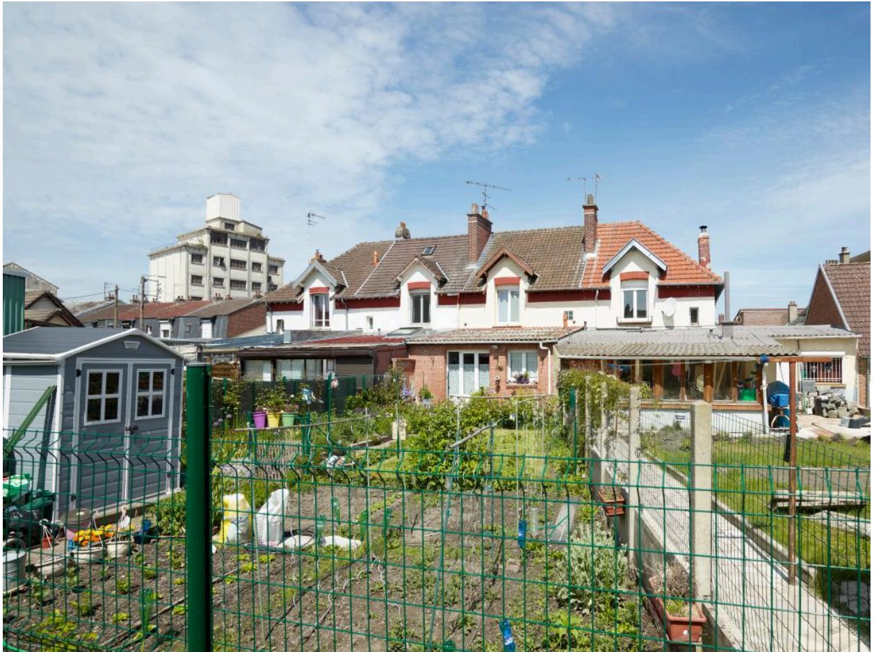
Groupe de quatre logements. Vue générale des façades arrières et des jardins des numéros 2 à 8 des maisons de la rue de la Liberté.
