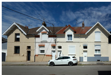
Groupe de quatre logements. Vue générale des façades des numéros 15 à 21 depuis la rue Marcellin-Gaudefroy. Phot. Delphine Volto-Jourdan IVR32_20216200578NUCA
