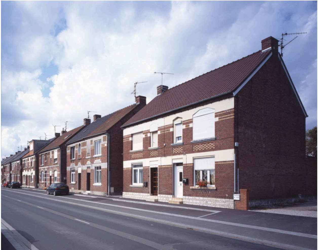
Alignement boulevard des Alliés.
