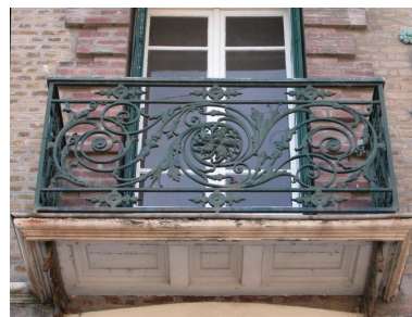
Détail du décor de fonte du garde- corps des balcons des étages-carrés. Phot. Elisabeth Justome IVR22_20058002533NUCA
