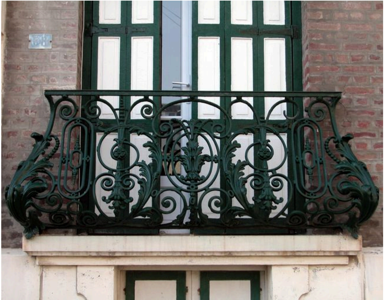
Détail du décor de fonderie des garde-corps des balconnets du rez-de-chaussée surélevé.
