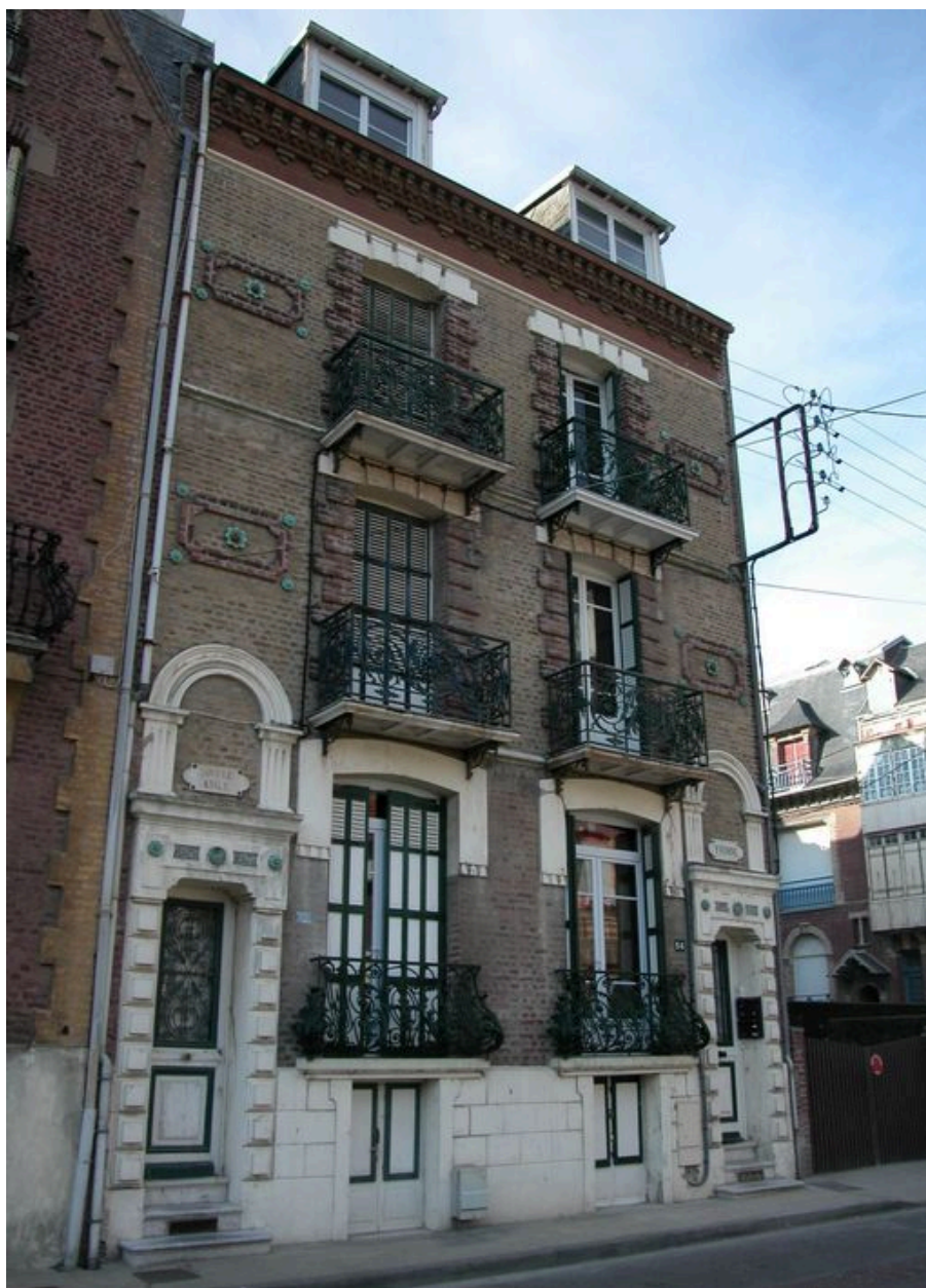
Vue d'ensemble depuis la rue.
