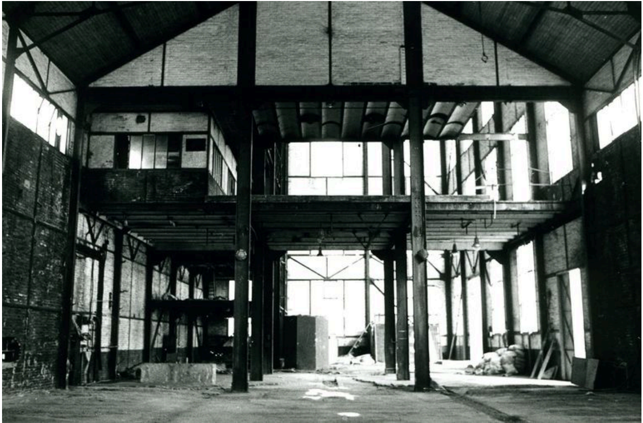
Atelier, vue intérieure.
