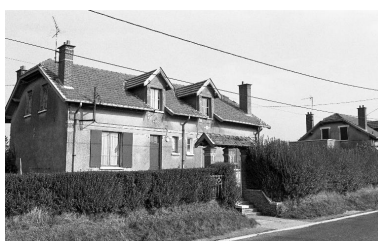
Logement d'ouvriers. Phot. Francis Dubuc IVR22_19908001180Z
