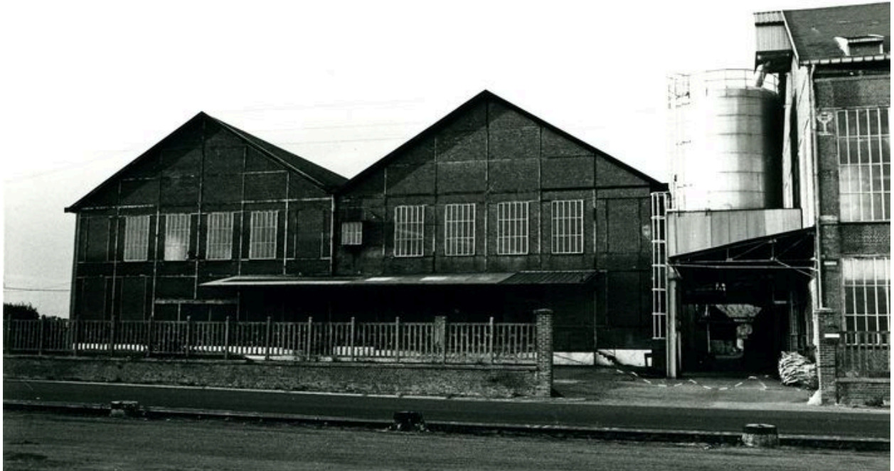
Atelier de fabrication, flanc sud.
