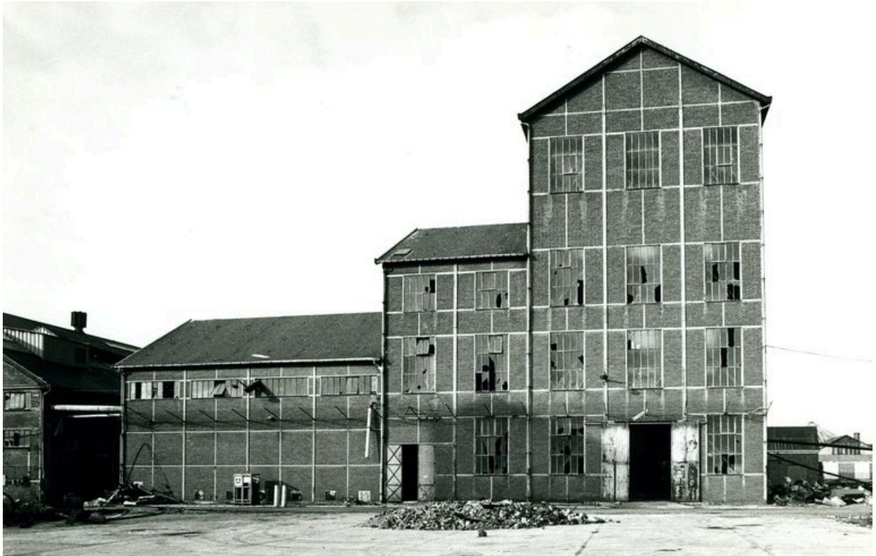
Atelier de fabrication, flanc est.
