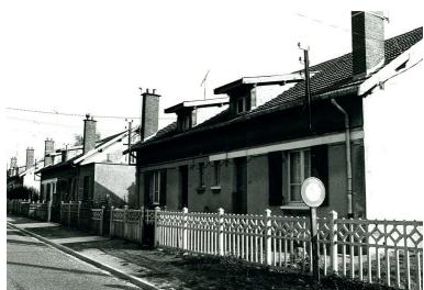
Logements d'ouvriers. Phot. Francis Dubuc IVR22_19908001179Z
