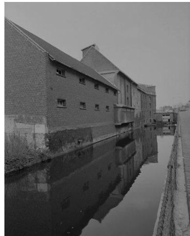
Vue générale, flanc nord. Phot. Thierry Lefébure IVR22_19908001842X
