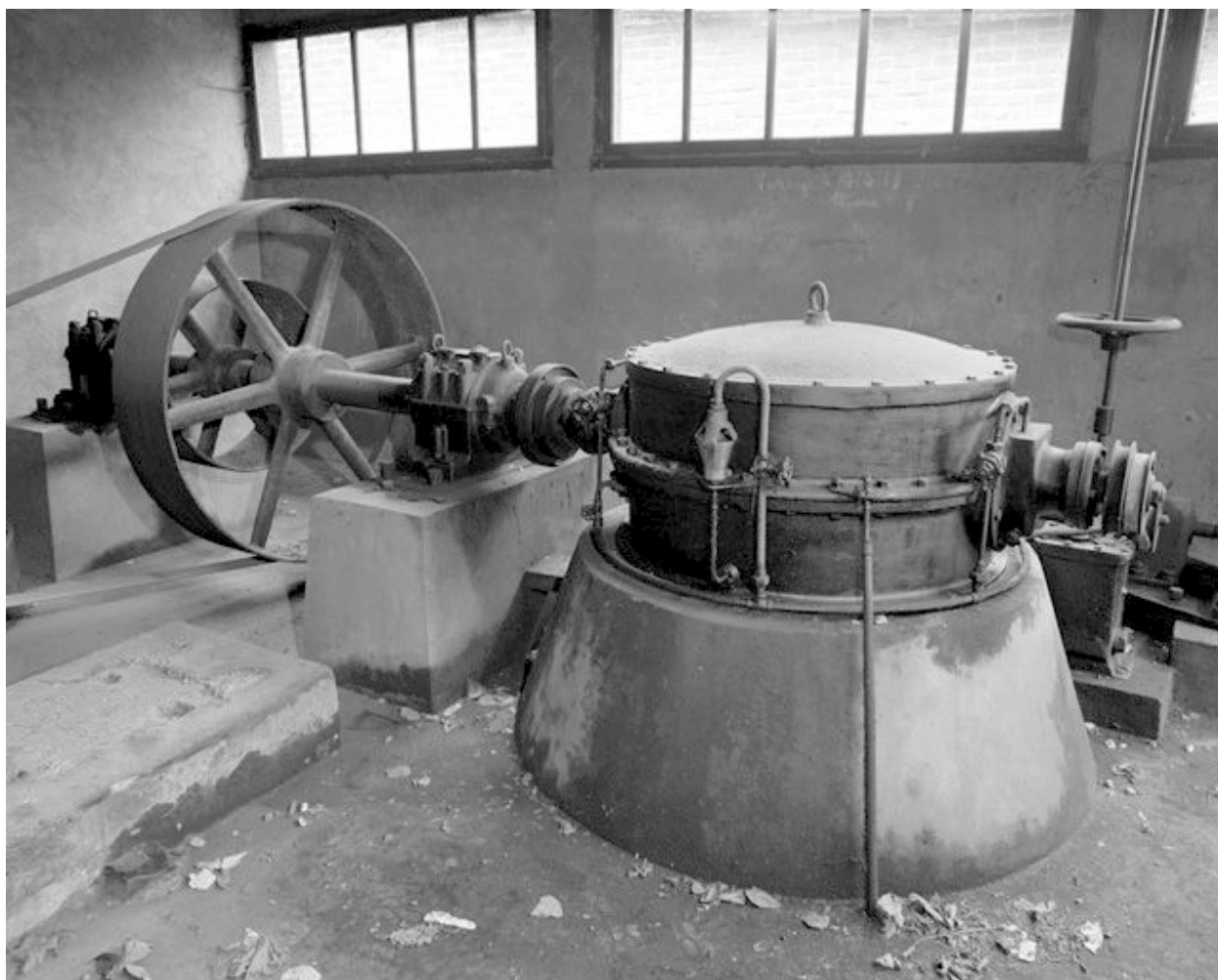
Bâtiment d'eau, vue intérieure.
