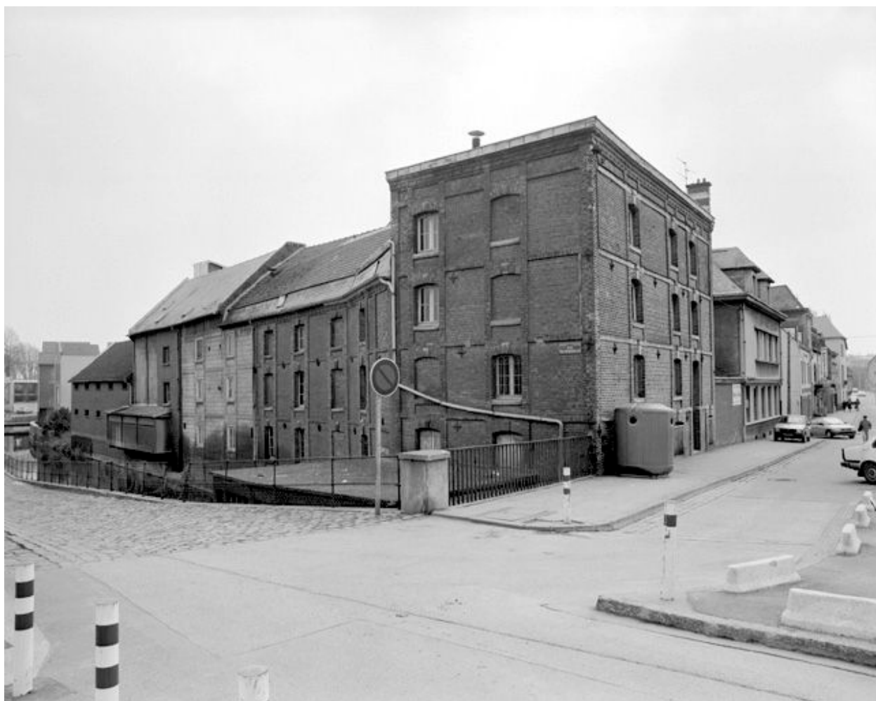
Vue générale, flanc nord-ouest.
