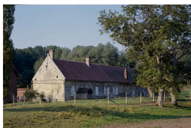
Logis. Elévation postérieure. Phot. Fabrice Charrondière IVR22_19866000201XA
