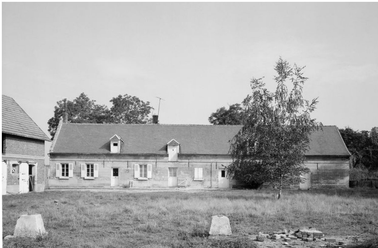
Logis. Elévation antérieure.
