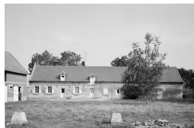
Logis. Elévation antérieure. Phot. Jean-Michel Perrin IVR22_19846001153X
