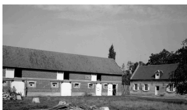
Bâtiments d'exploitation. Phot. Jean-Michel Perrin IVR22_19846001154X
