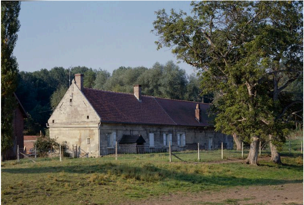
Logis. Elévation postérieure.
