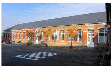
Façade sur cour des salles de classe. Phot. Bertrand Fournier IVR22_20138016096NUC2A
