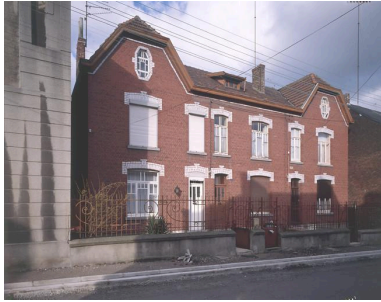
Élévations antérieures. Phot. Olivier Marlard IVR31_19945900486VA
