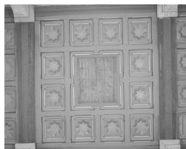
Vue de détail : caisson du plafond des bas-côtés. Phot. Thierry Lefébure IVR22_19968000214X
