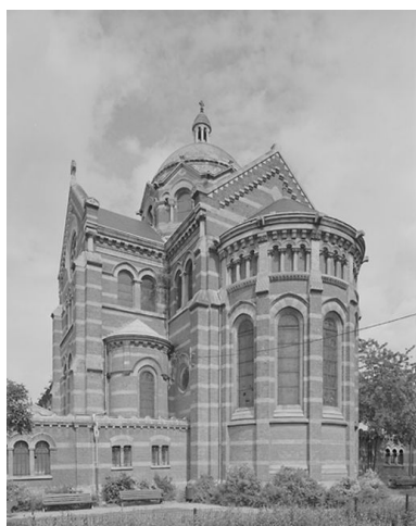
Vue générale depuis le nord-est. Phot. Thierry Lefébure IVR22_19968000206V
