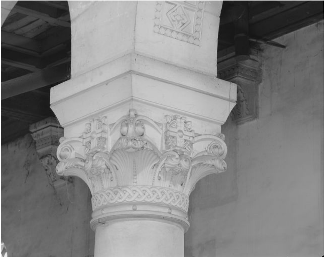
Vue de détail : chapiteau de la nef.
