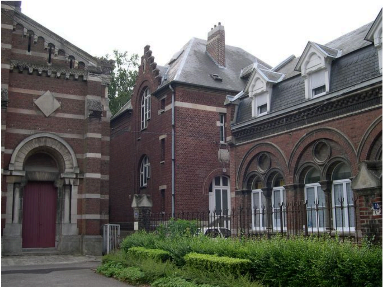
Bâtiment au sud de l'église, vue depuis le nord-ouest.
