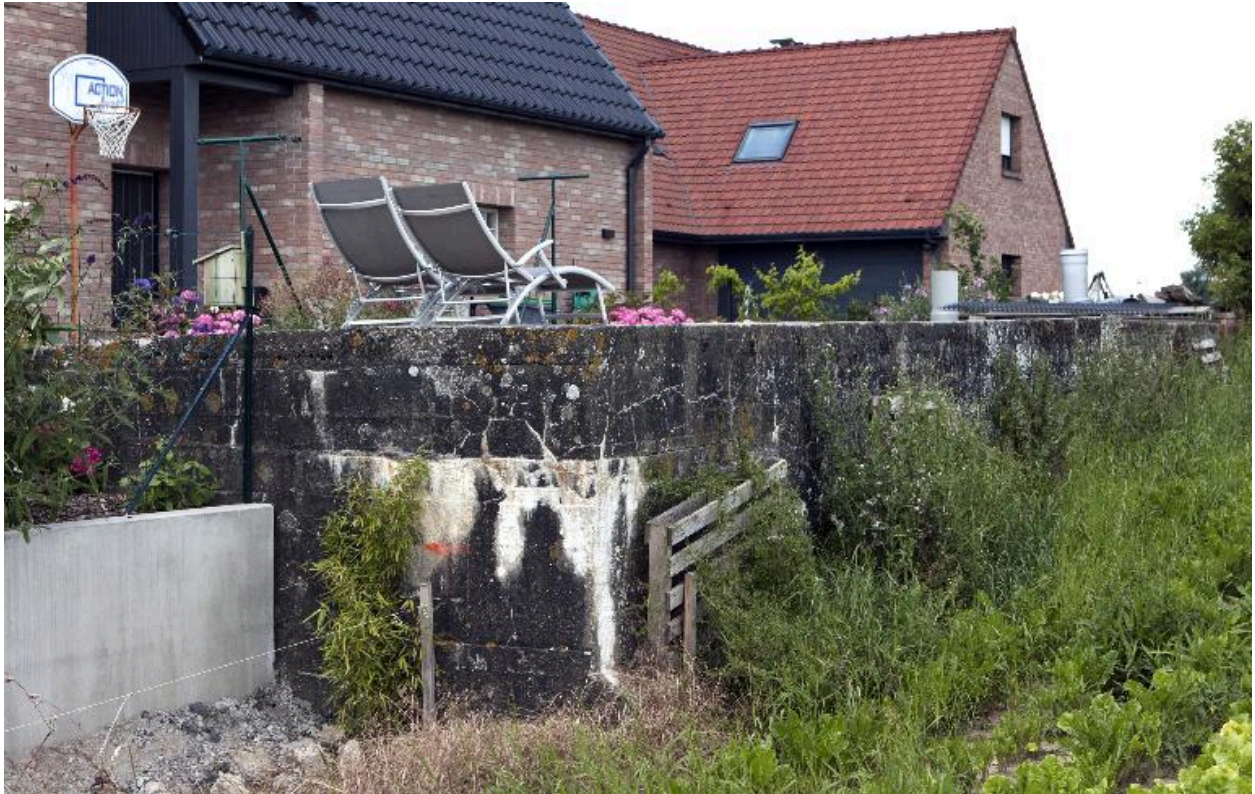
Vue de trois-quarts vers le nord-ouest
