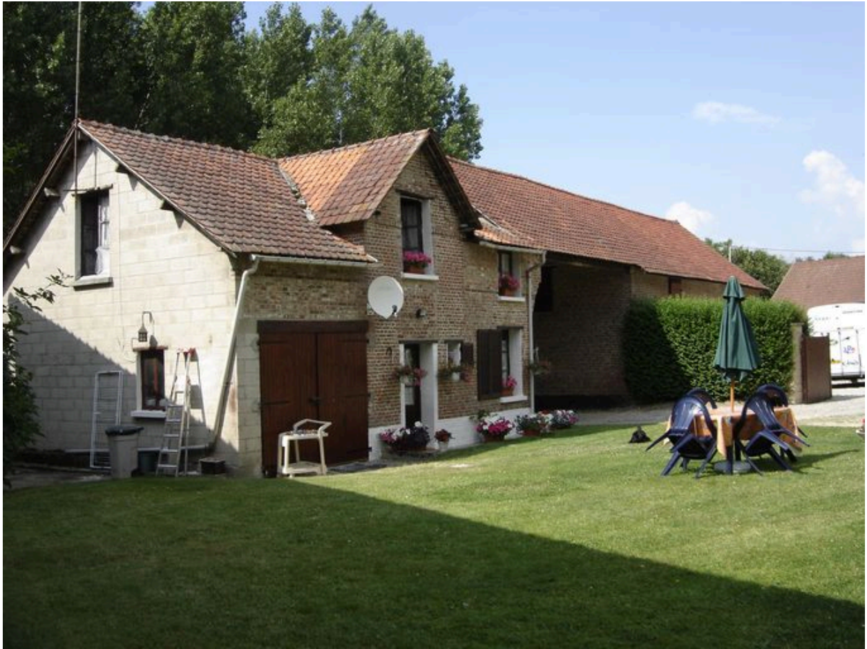
Vue des étables surmontées d'un fenil.
