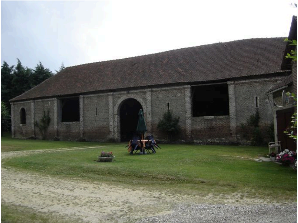
Vue de la grange.
