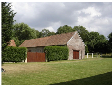
Vue latérale des écuries. Phot. Inès Guérin IVR22_20058006224NUCA
