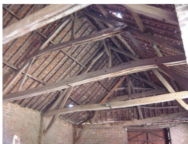
Vue de la charpente. Phot. Inès Guérin IVR22_20058006228NUCA
