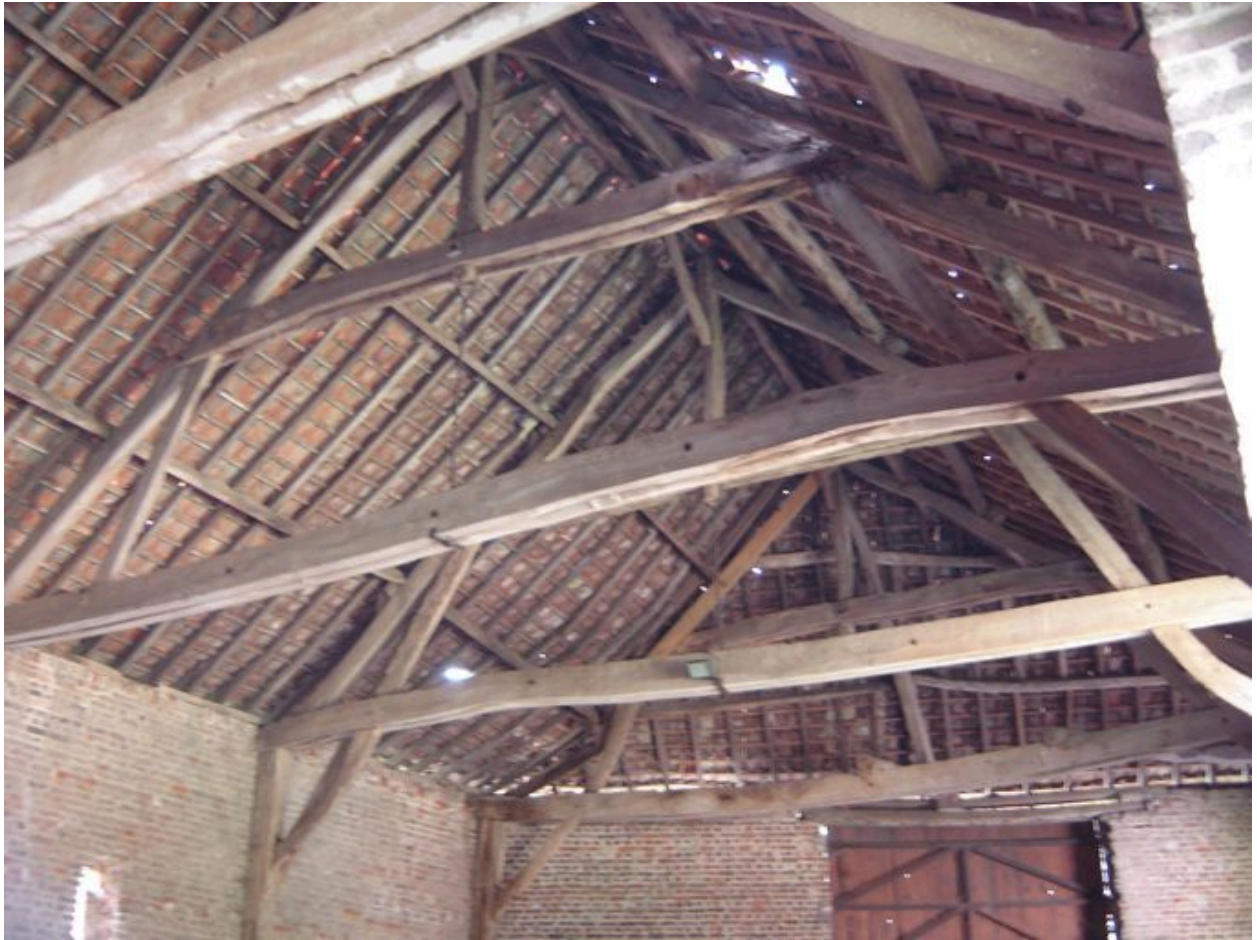
Vue de la charpente.
