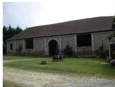
Vue de la grange. Phot. Inès Guérin IVR22_20058006226NUCA
