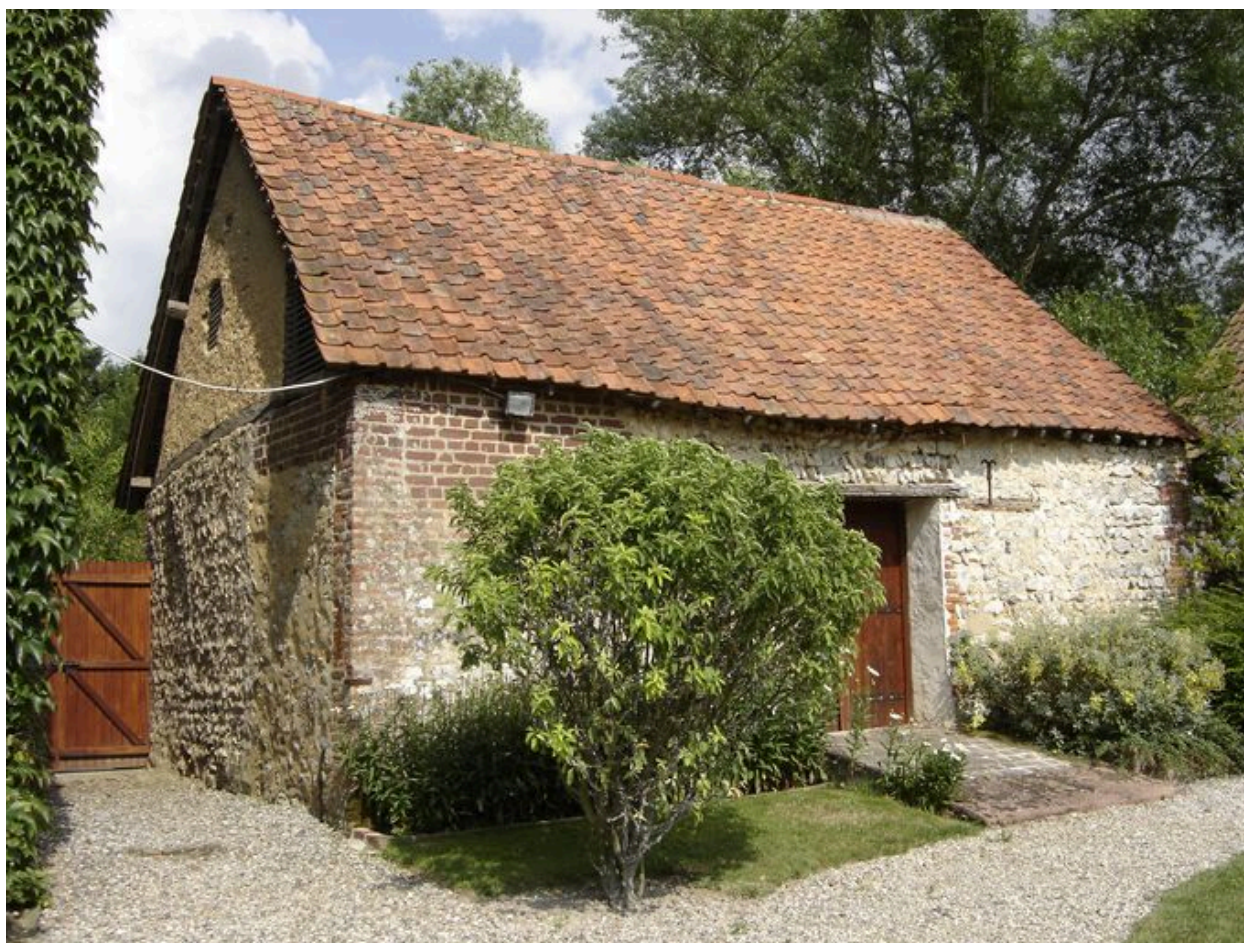
Vue de la remise.
