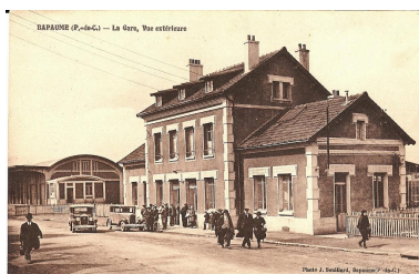
Bapaume (P.-de-C.) - La gare, vue extérieure. Photo J. Souillard, Bapaume. Carte postale, vers 1930. (Coll. part.). Vue générale de la place de la gare reconstruite.
