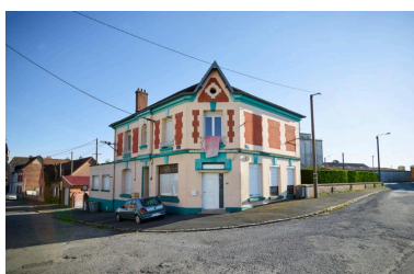
Vue des façades et du pan coupé depuis la rue de la gare de l'ancienne maison-estaminet de Mme veuve Angéline Leclercq-Verdel. Construit entre 1921 et 1928 par Eugène Bidard (AD Pas-de-Calais, 10R9/48, dossier n°696).
