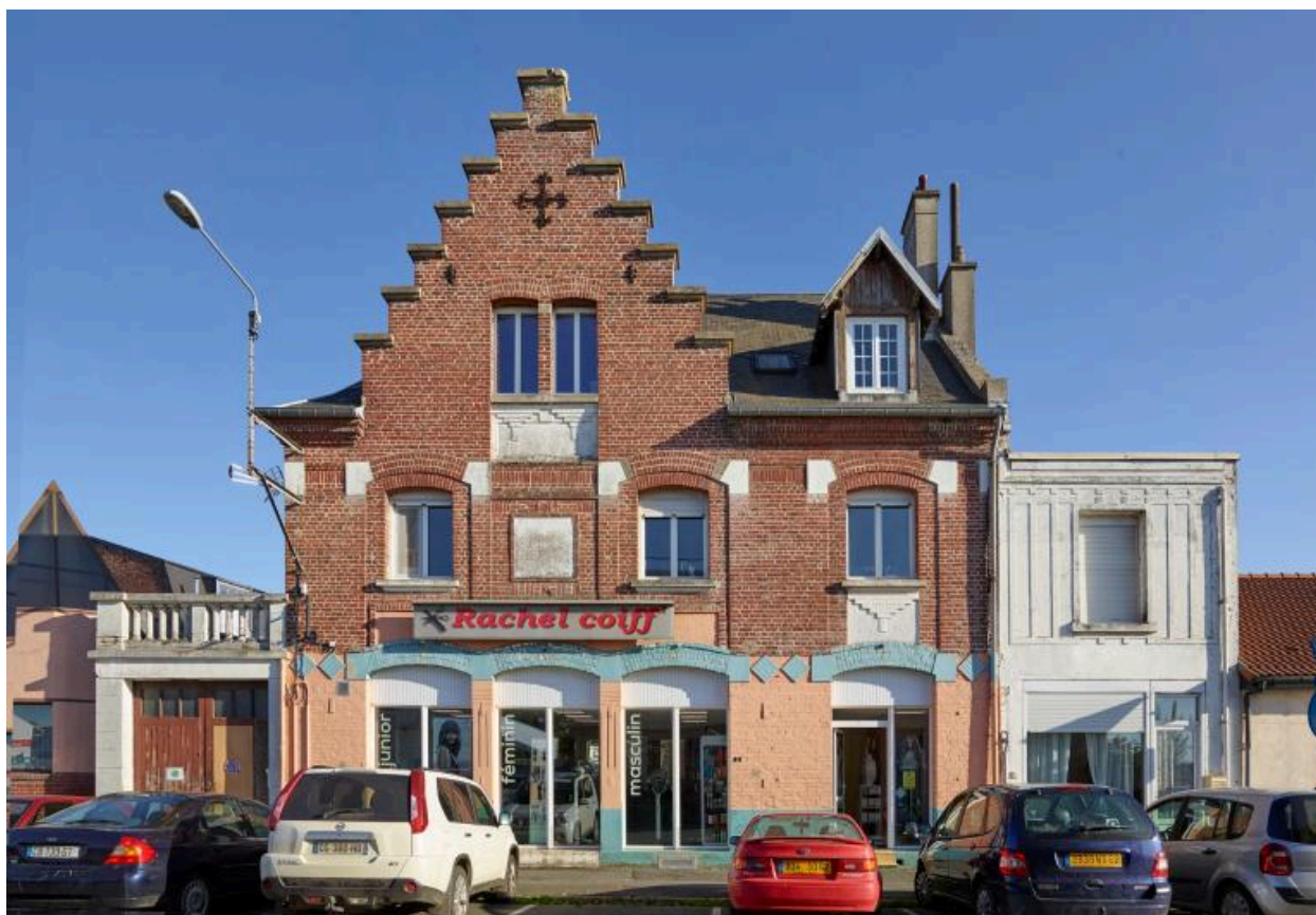
Maison de commerce avec pignon à redents, place de la gare.
