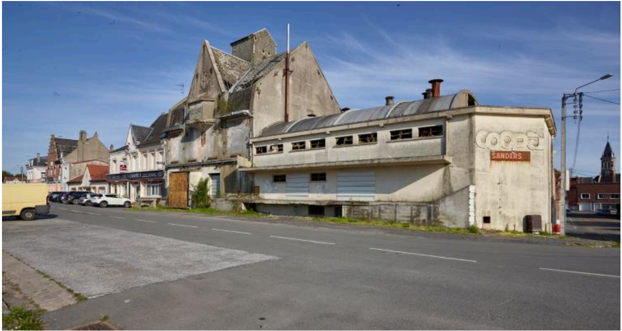
Vue générale côté sud.
