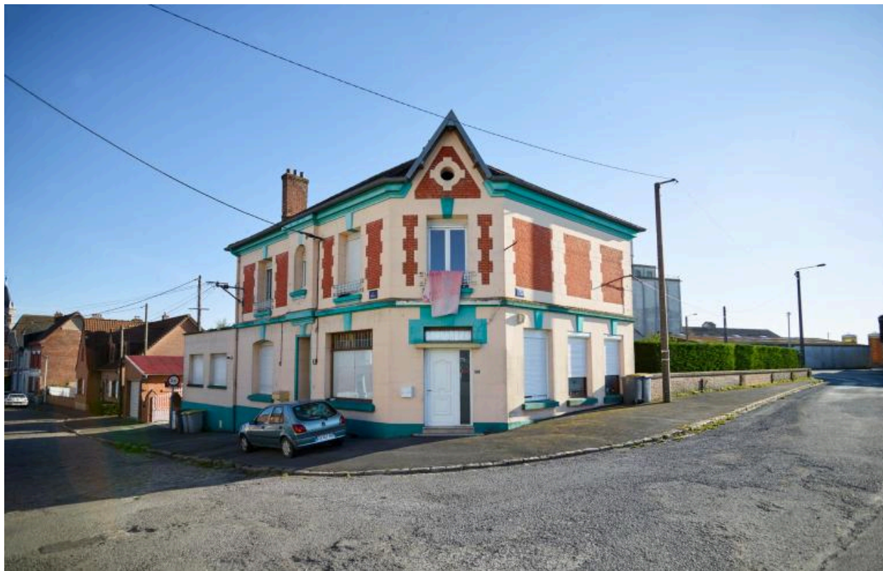
Vue des façades et du pan coupé depuis la rue de la gare de l'ancienne maison-estaminet de Mme veuve Angéline Leclercq-Verdel. Construit entre 1921 et 1928 par Eugène Bidard (AD Pas-de-Calais, 10R9/48, dossier n°696).
