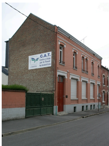
Façade des bureaux et ateliers, rue de Lunéville. Phot. Frédéric Pillet IVR22_20040200915NUCA
