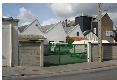
Les ateliers, vus depuis la rue Louise-Hugues. Phot. Frédéric Pillet IVR22_20040200916NUCA
