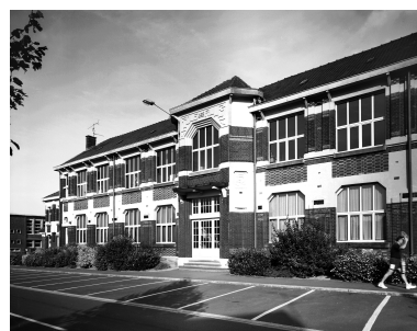
Vue générale de l'école. Phot. Thierry Petitberghien IVR31_20025902007V
