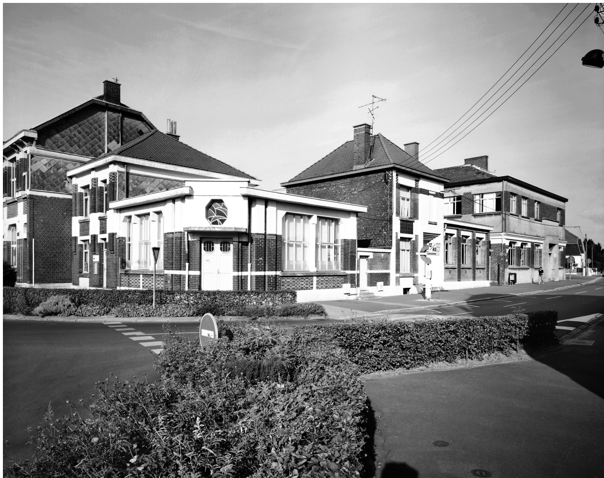
Vue générale de l'ancienne poste et des bains douches.
