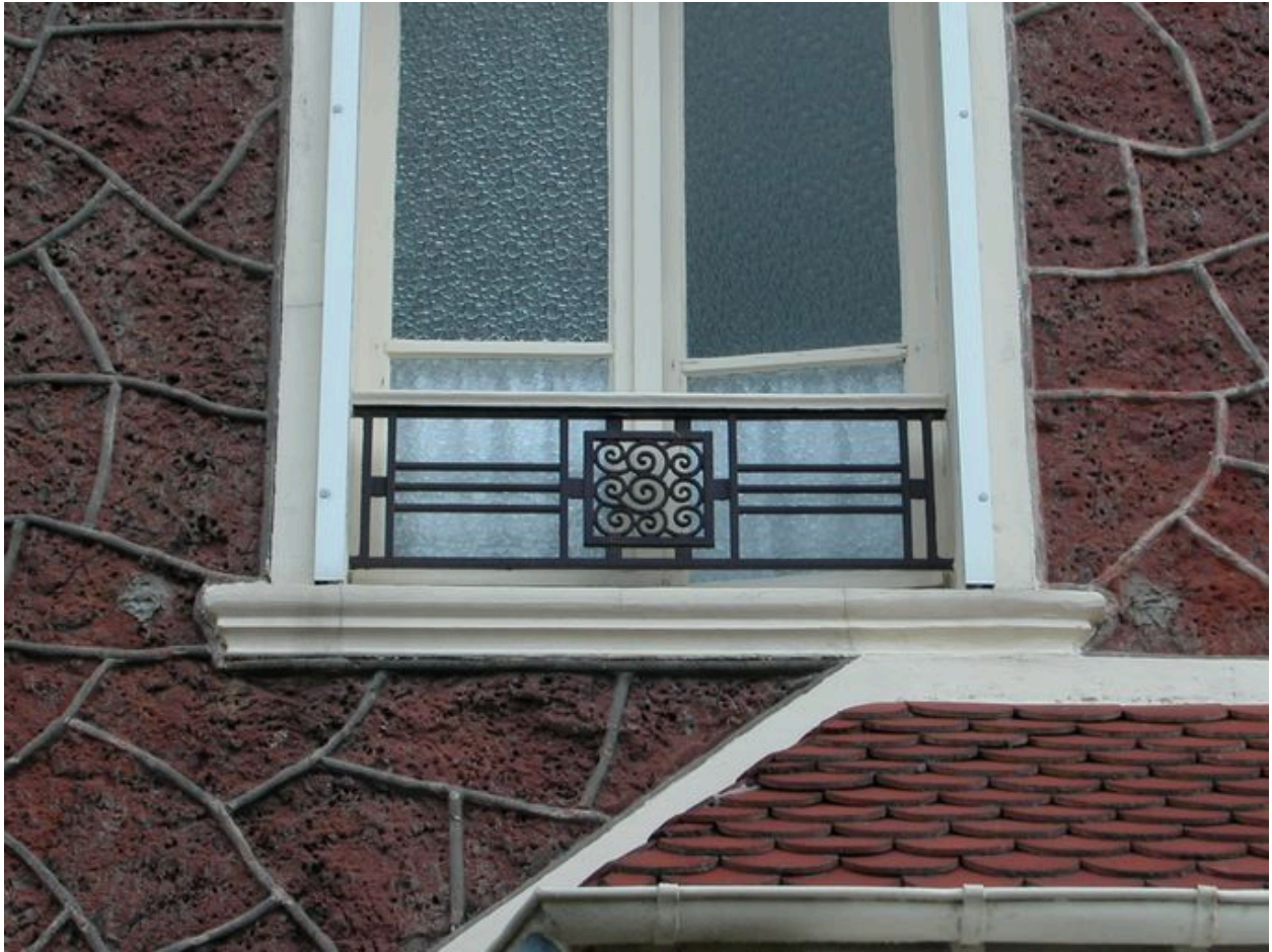
Détail du décor de fonderie des garde-corps.
