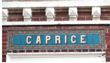
Détail des carreaux de céramique portant appellation. Phot. Elisabeth Justome IVR22_20058003072NUCA
