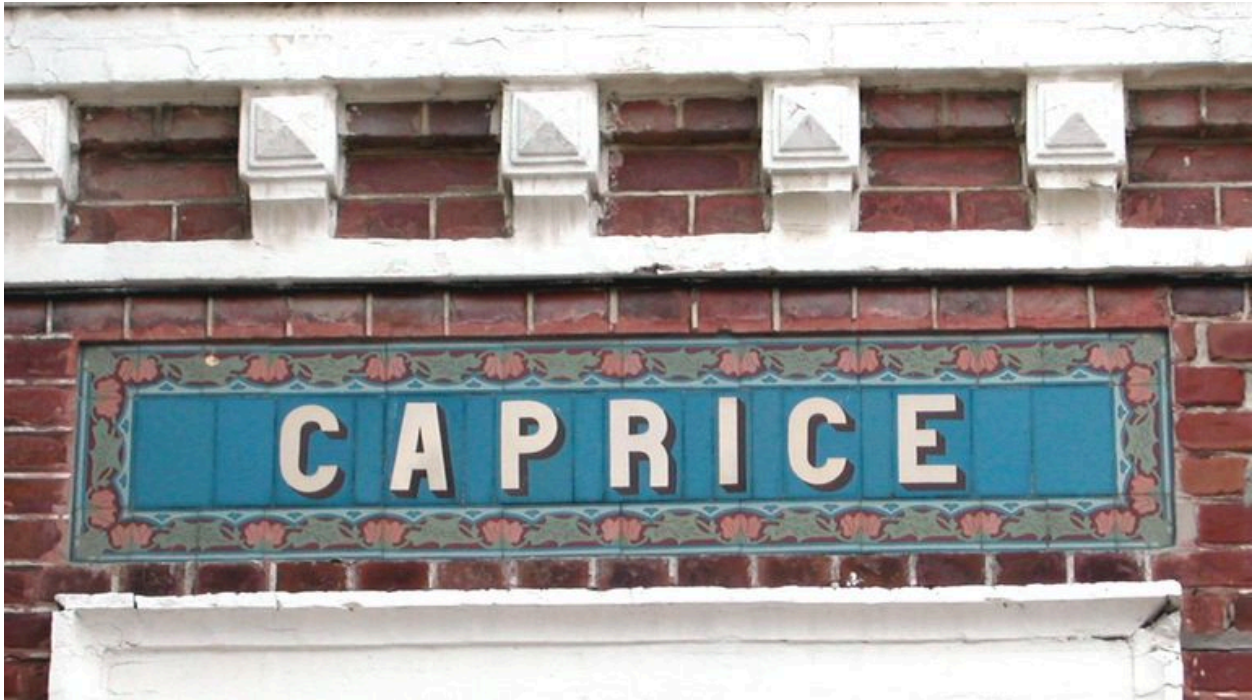
Détail des carreaux de céramique portant appellation.
