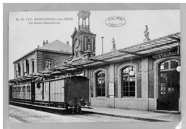
Façade sur voie ferrée, train, carte postale. B.M. Boulogne-sur-Mer, albums cartes postales. Repro. Philippe Dapvril IVR31_19946200073XB
