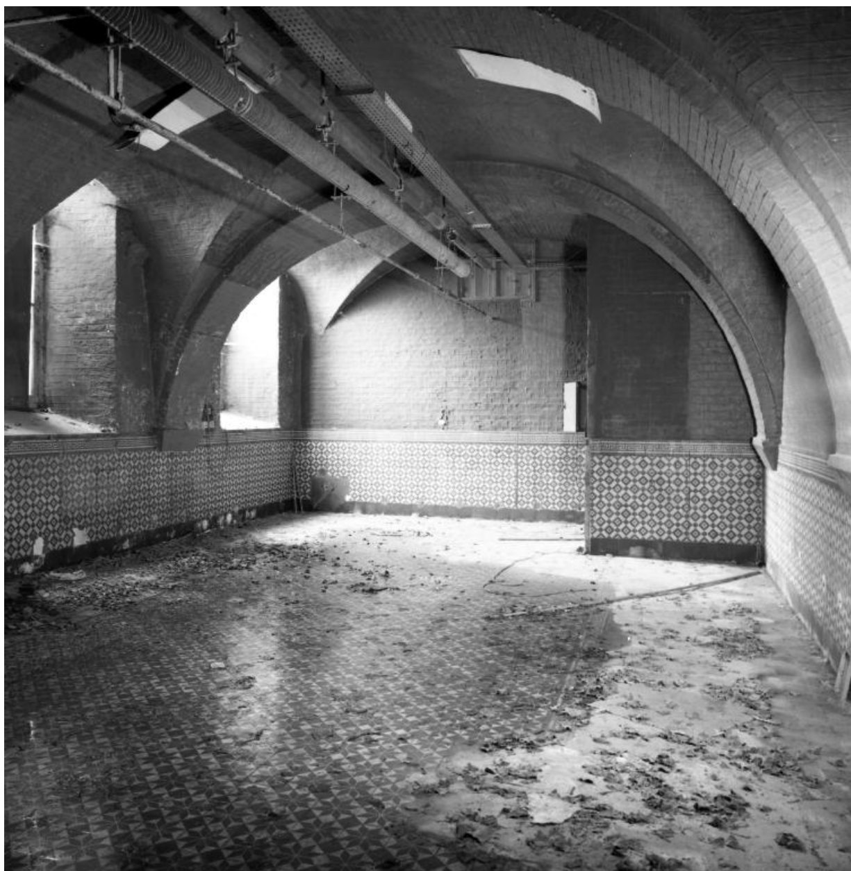
Bâtiment situé à droite en entrant dans la cour d'honneur et donc sur son flanc sud, sous-sol, salle ayant servi au 19 e siècle d'atelier de menuiserie, vue générale.
