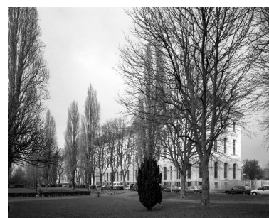
Bâtiment principal, élévation antérieure donnant sur l'avenue du Peuple-Belge, vue générale prise de trois-quarts droit. Phot. Philippe Dapvril IVR31_20005900508V
