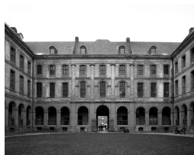
Cour d'honneur, élévation du revers du bâtiment principal donnant sur l'avenue du Peuple-Belge. Phot. Philippe Dapvril IVR31_20005900505V
