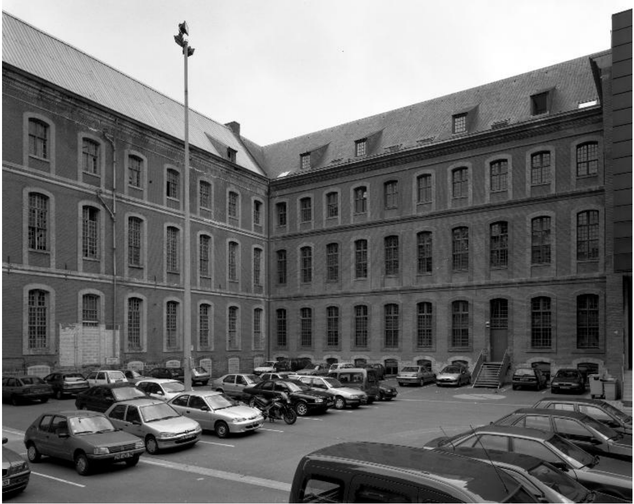
Cour située au nord de la cour d'honneur, appelée autrefois cour des femmes, élévation des deux bâtiments subsistants.
