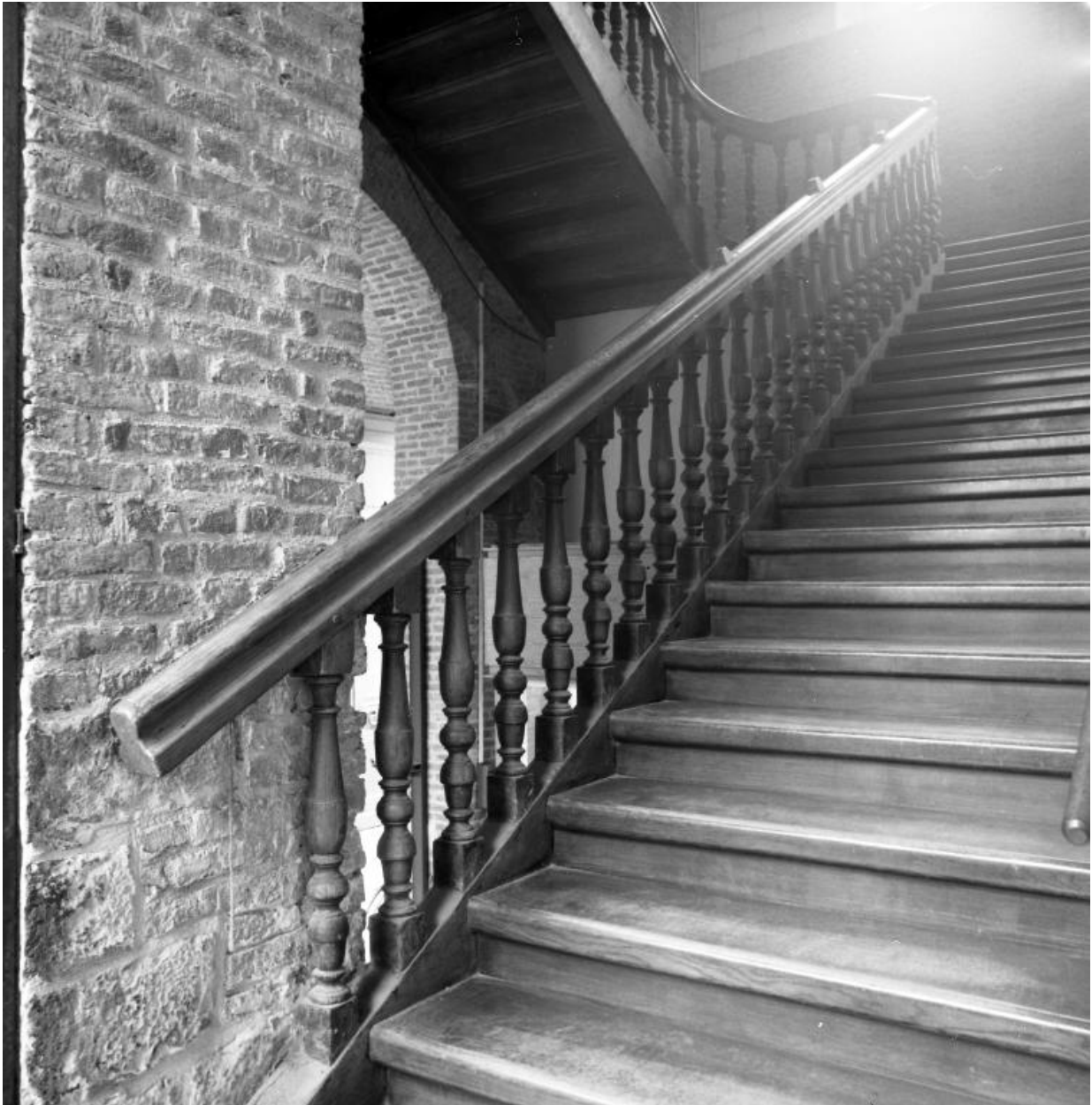
Bâtiment principal donnant sur l'avenue du Peuple-Belge, escalier situé immédiatement à gauche du passage d'entrée, départ.
