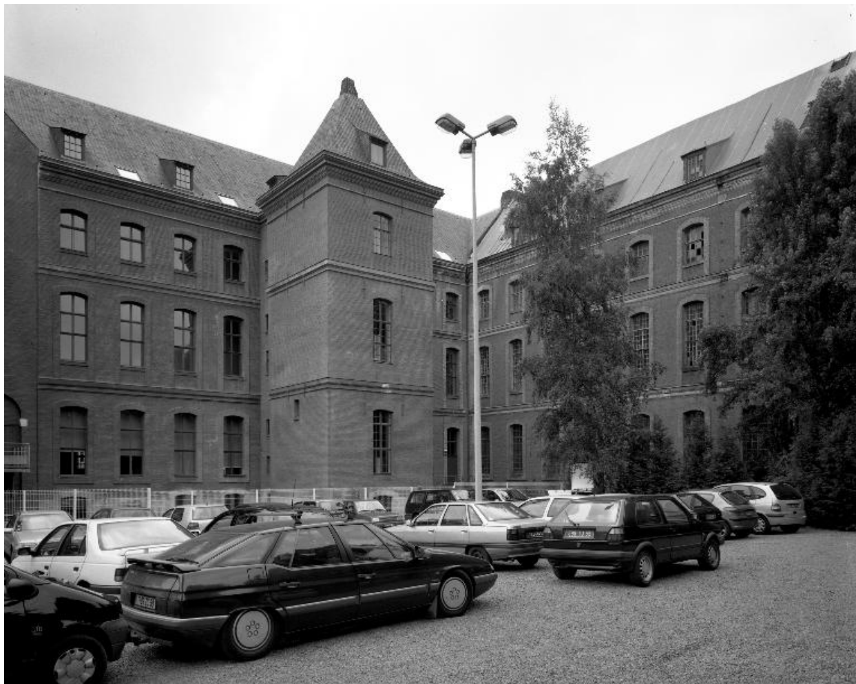
Cour située au sud de la cour d'honneur, appelée autrefois cour des soeurs, élévation des deux bâtiments subsistants avec, en saillie sur l'un d'entre eux, le pavillon des latrines.
