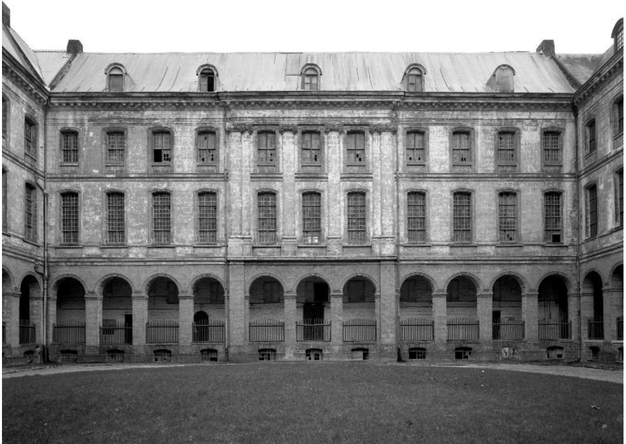
Cour d'honneur, élévation du bâtiment situé à droite en entrant dans la cour et donc sur le flanc sud.
