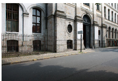
Bâtiment principal, élévation donnant sur l'avenue du Peuple-Belge, avant-corps central, détail de son niveau de rez-de-chaussée. Phot. Pierre Thibaut IVR31_20145902441NUCA
