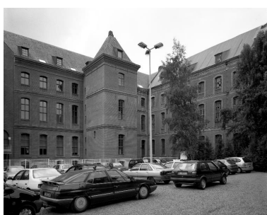
Cour située au sud de la cour d'honneur, appelée autrefois cour des soeurs, élévation des deux bâtiments subsistants avec, en saillie sur l'un d'entre eux, le pavillon des latrines. Phot. Philippe Dapvril IVR31_20015901516V
