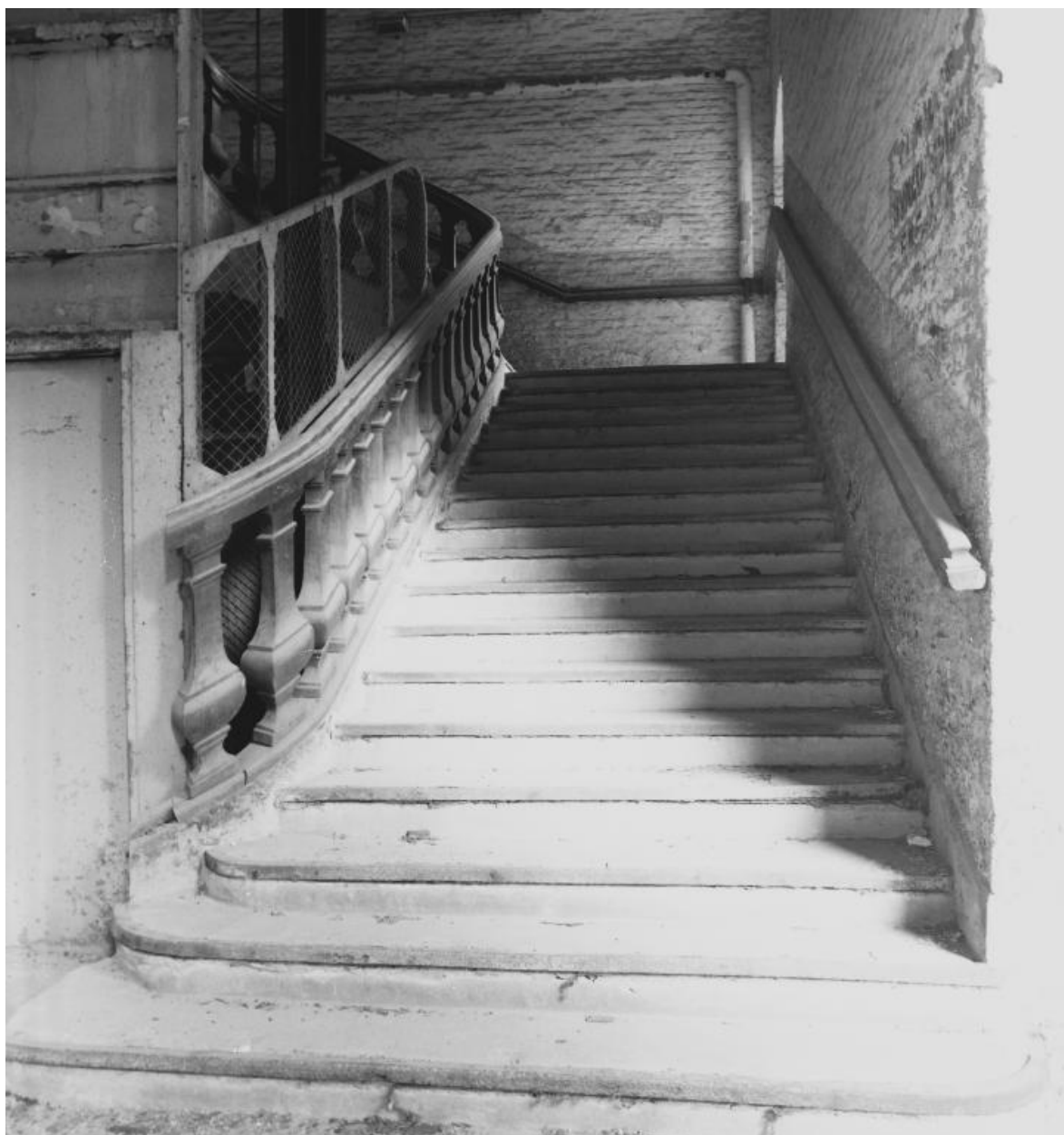
Escalier situé à l'angle du bâtiment fermant le fond de la cour d'honneur et de celui situé à gauche en entrant dans cette même cour et donc sur le flanc nord, départ.
