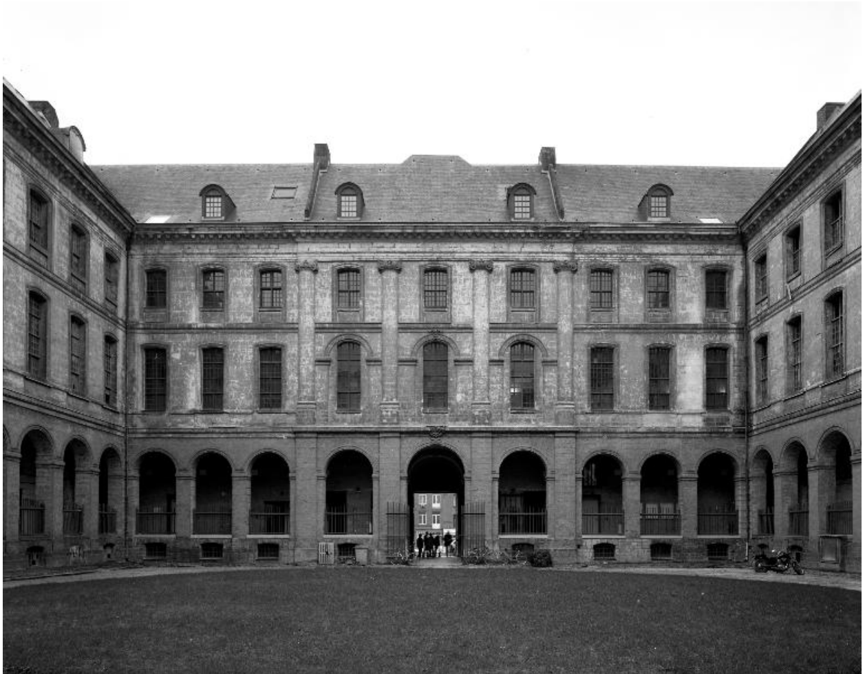
Cour d'honneur, élévation du revers du bâtiment principal donnant sur l'avenue du Peuple-Belge.
