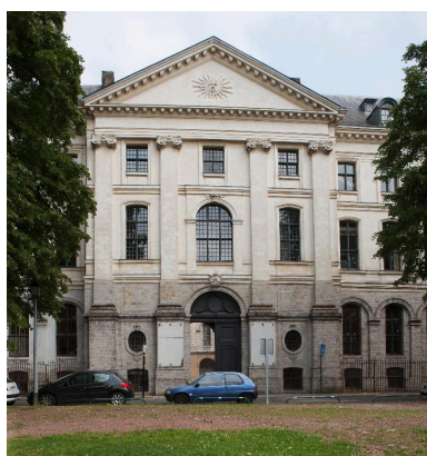
Bâtiment principal, élévation donnant sur l'avenue du Peuple-Belge, avant-corps central, vue générale. Phot. Pierre Thibaut IVR31_20145902440NUCA
