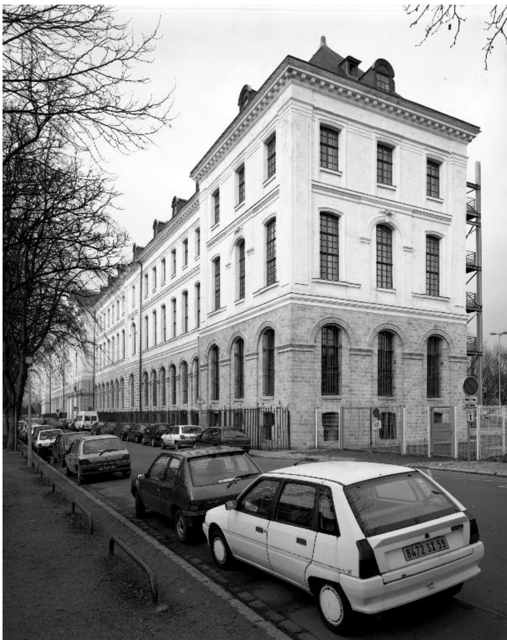
Bâtiment principal, élévation donnant sur l'avenue du Peuple-Belge, vue générale prise en enfilade depuis le flanc sud.
