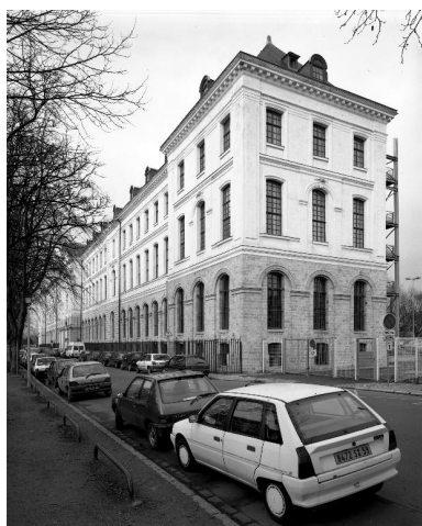
Bâtiment principal, élévation donnant sur l'avenue du Peuple-Belge, vue générale prise en enfilade depuis le flanc sud. Phot. Philippe Dapvril IVR31_20005900506V
