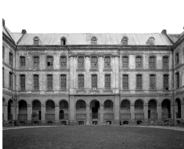
Cour d'honneur, élévation du bâtiment situé à droite en entrant dans la cour et donc sur le flanc sud. Phot. Philippe Dapvril IVR31_20005900509V
