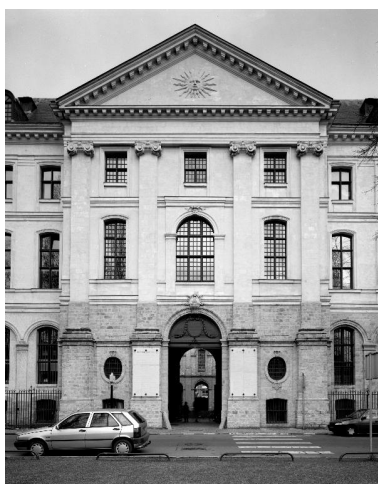
Bâtiment principal, élévation donnant sur l'avenue du Peuple-Belge, détail de l'avant-corps central. Phot. Philippe Dapvril IVR31_20005900510V
