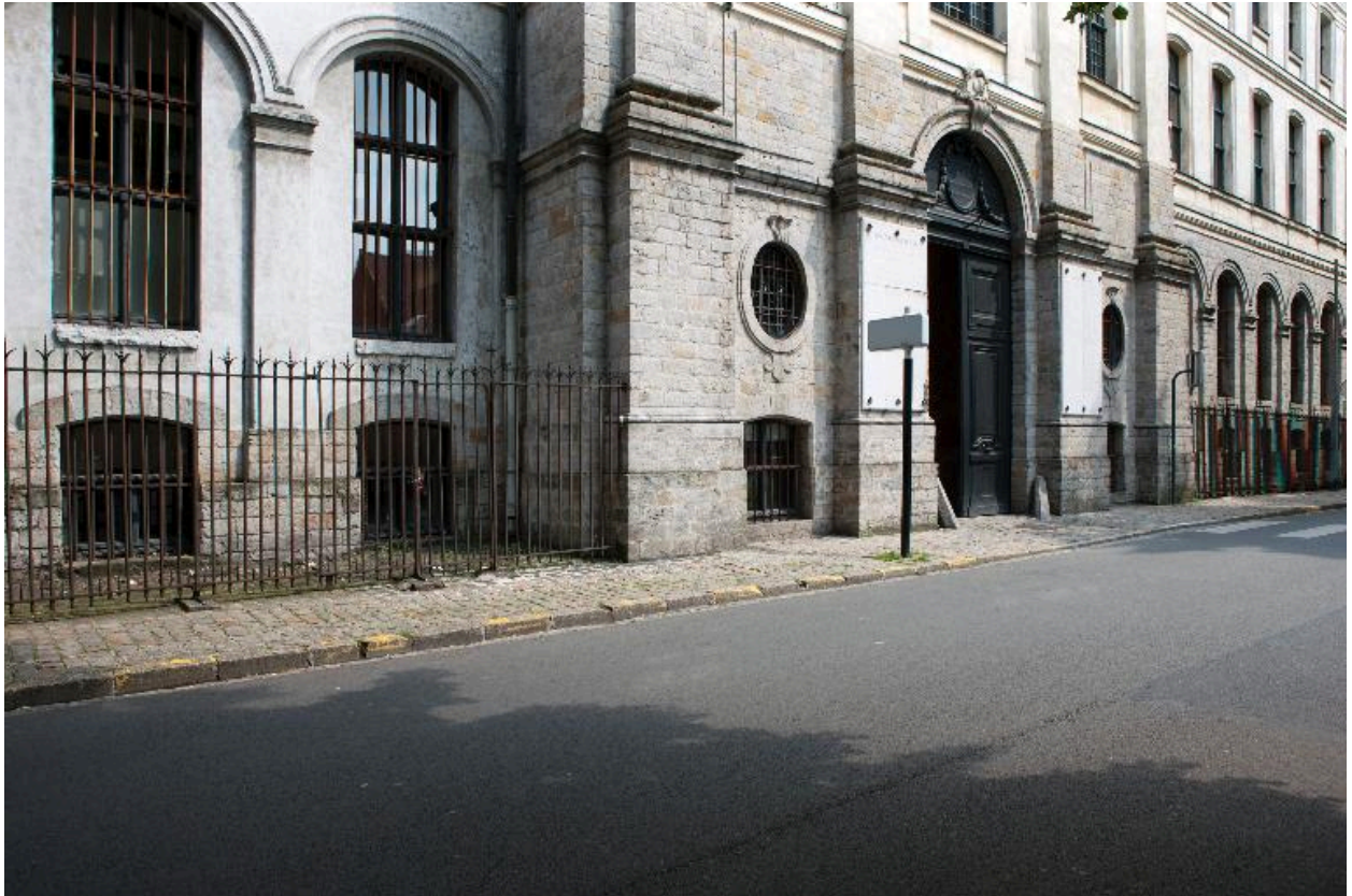
Bâtiment principal, élévation donnant sur l'avenue du Peuple-Belge, avant-corps central, détail de son niveau de rez-de-chaussée.
