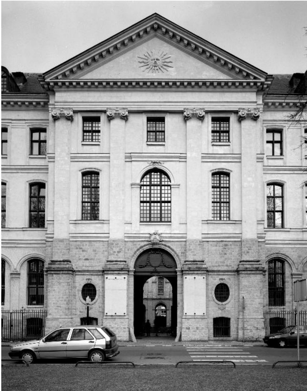
Bâtiment principal, élévation donnant sur l'avenue du Peuple-Belge, détail de l'avant-corps central.
