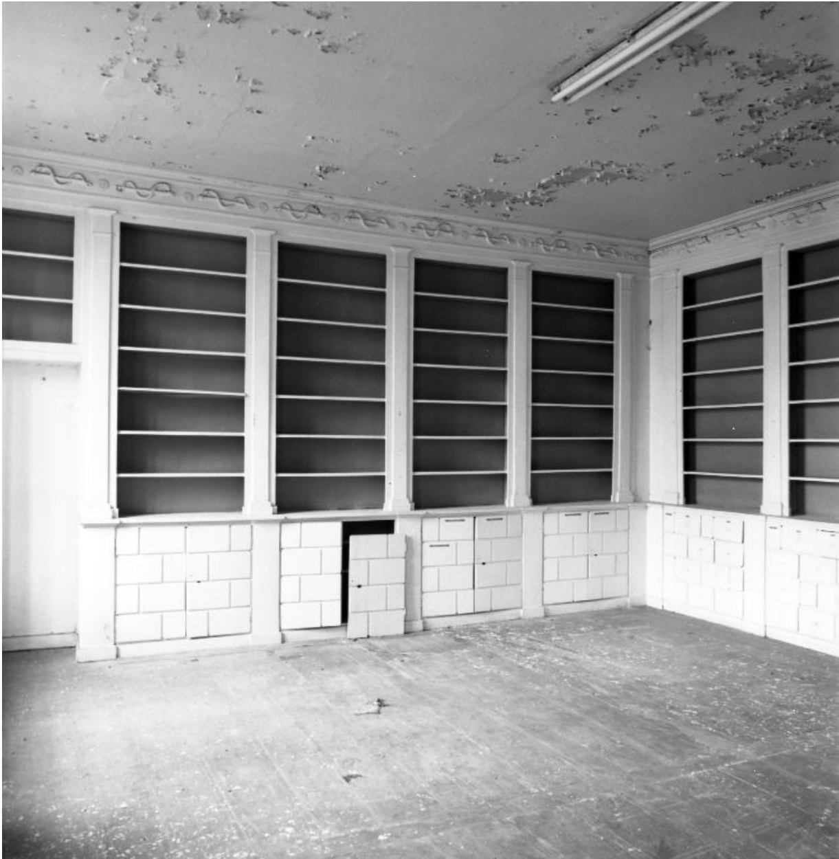
Bâtiment situé à droite en entrant dans la cour d'honneur et donc sur son flanc sud, rez-de-chaussée, ancienne pharmacie, vue générale.
