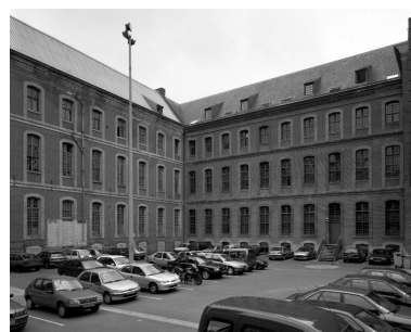
Cour située au nord de la cour d'honneur, appelée autrefois cour des femmes, élévation des deux bâtiments subsistants. Phot. Philippe Dapvril IVR31_20015901513V
