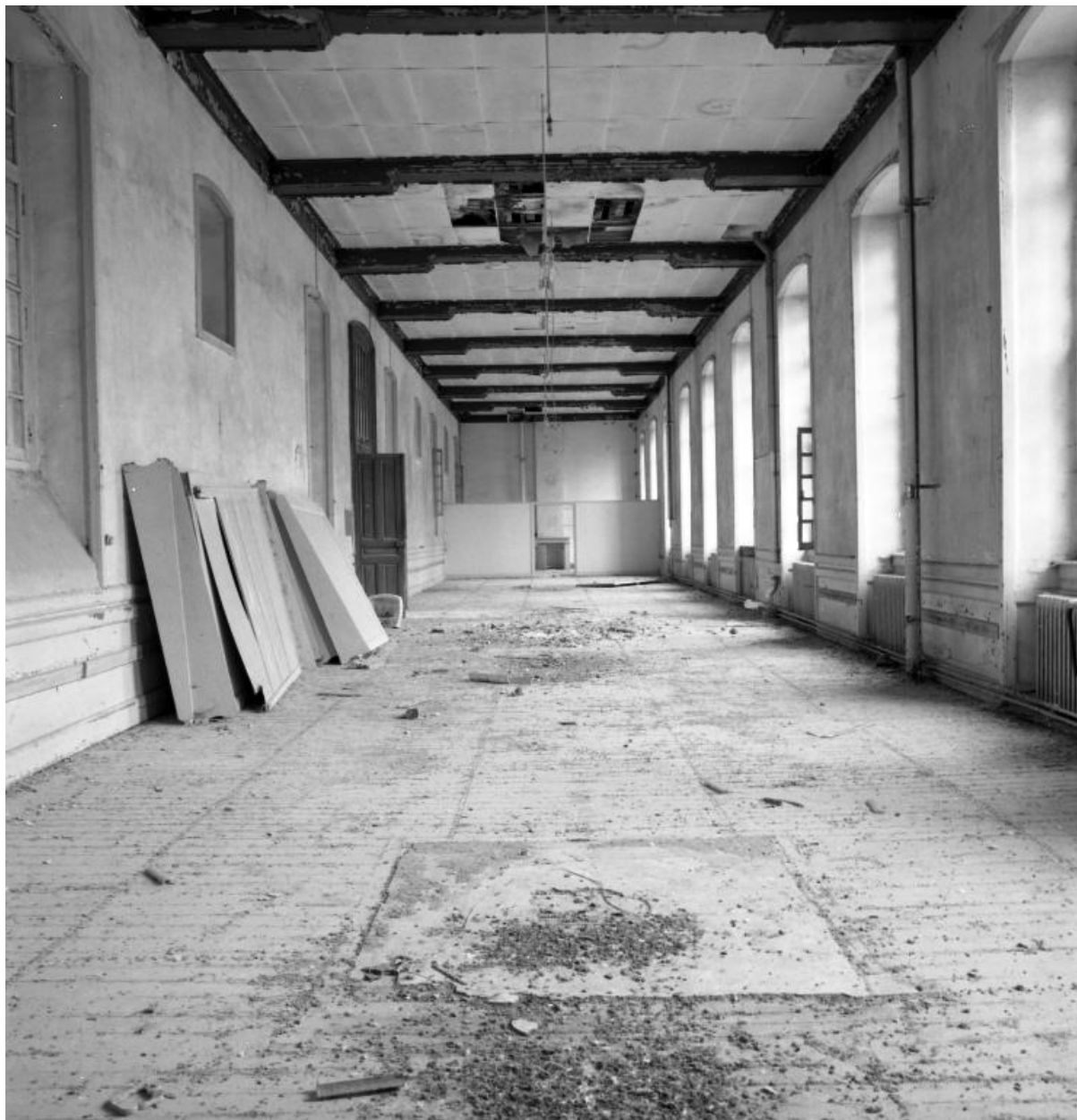
Bâtiment situé à gauche en entrant dans la cour d'honneur et donc sur son flanc nord, 1er étage, ancienne salle commune, vue générale.
