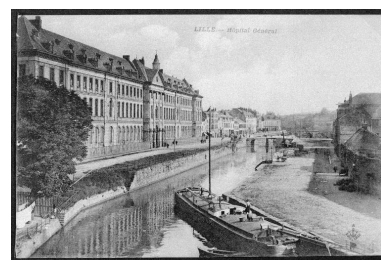
Façade principale donnant sur le canal de la Basse-Deûle, vue de trois-quarts gauche, carte postale, 1er quart du 20e siècle (collection particulière, Carlos Bocquet). Phot. Caudroit Philippe IVR31_19795900236XB
