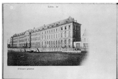
Façade principale donnant sur le canal de la Basse-Deûle, vue de trois-quarts droit (collection particulière, Carlos Bocquet). Phot. Caudroit Philippe IVR31_19795900723XB
